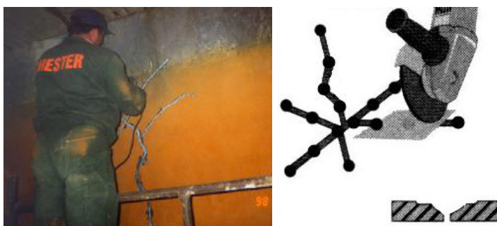
Rys. 7.3. Ukosowanie i chropowacenie dużego pęknięcia w zbiorniku
