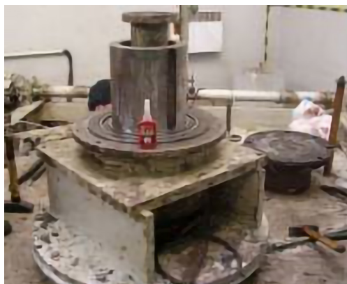
Rys. 10.2. Osadzanie łożyska w turbinie wodnej napędzającej generator
