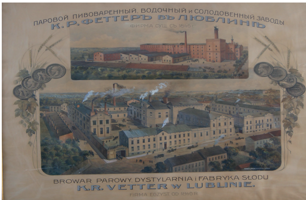
Ryc. 23. Widok ogólny browaru przy ul. Bernardyńskiej i słodownia przy ul. Misjonarskiej – 1913 r., Eckert & Pflug; fot. K. Janus
