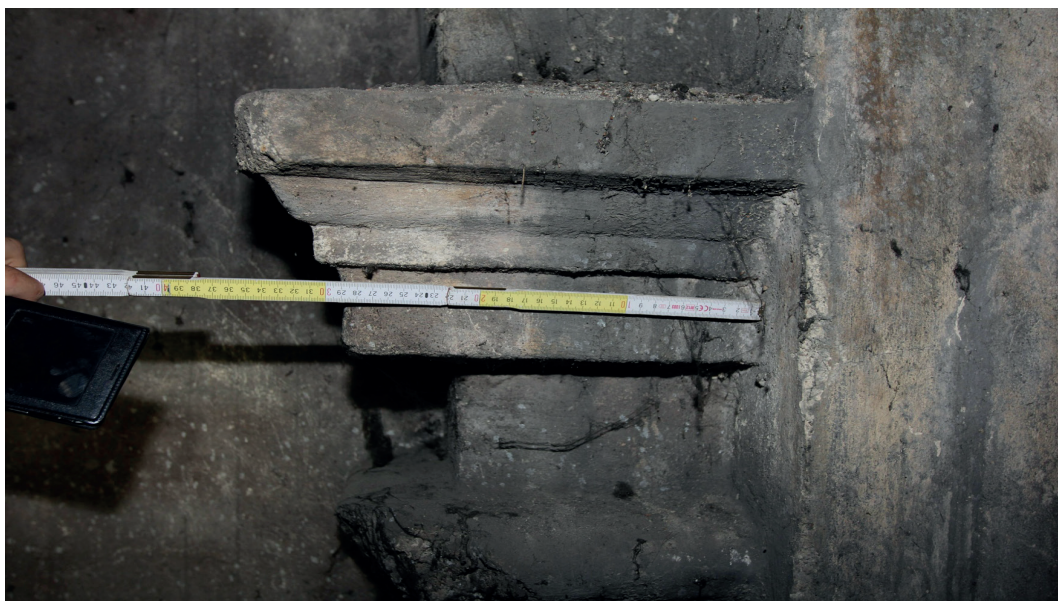
Fot. 28. Fragment gzymsu elewacji południowej kościoła zachowany pod dachem klasztoru; fot. K. Janus
