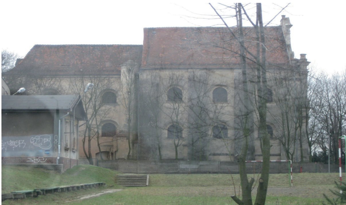
Fot. 18. Elewacja kościoła poreformackiego w Poznaniu – 2016 r.; fot. K. Janus
