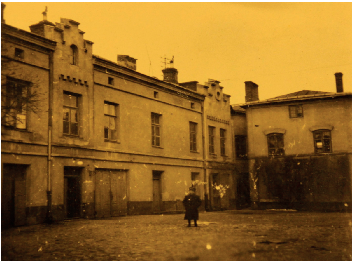
Ryc. 36. Widok budynku S od strony podwórka – 1937 r.; APL, BGK, sygn. 54, s. 3
