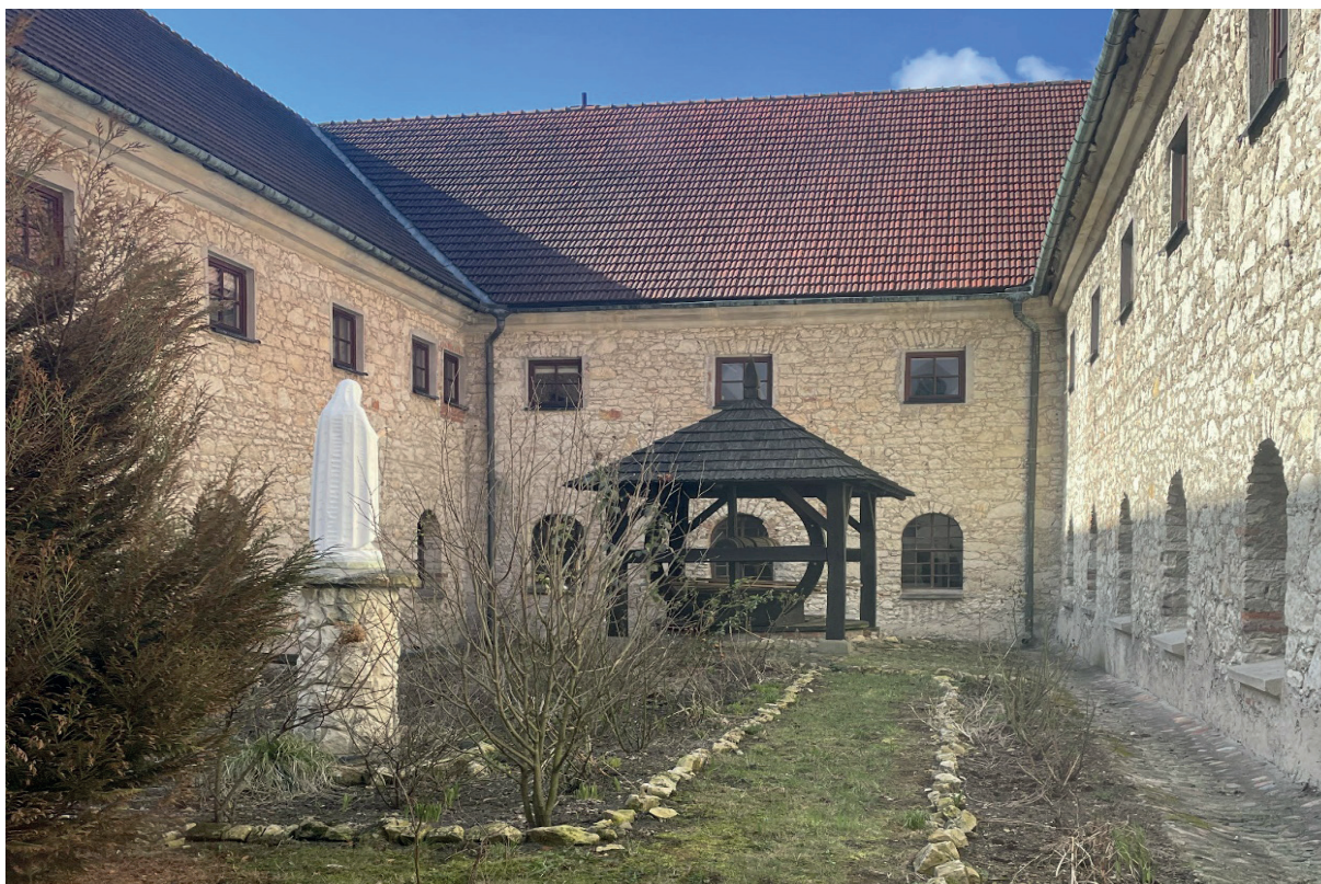
Ryc. 9. Wirydarz ze studnią dawnego klasztoru Reformatów w Kazimierzu Dolnym; fot. K. Janus, 2023 r.
