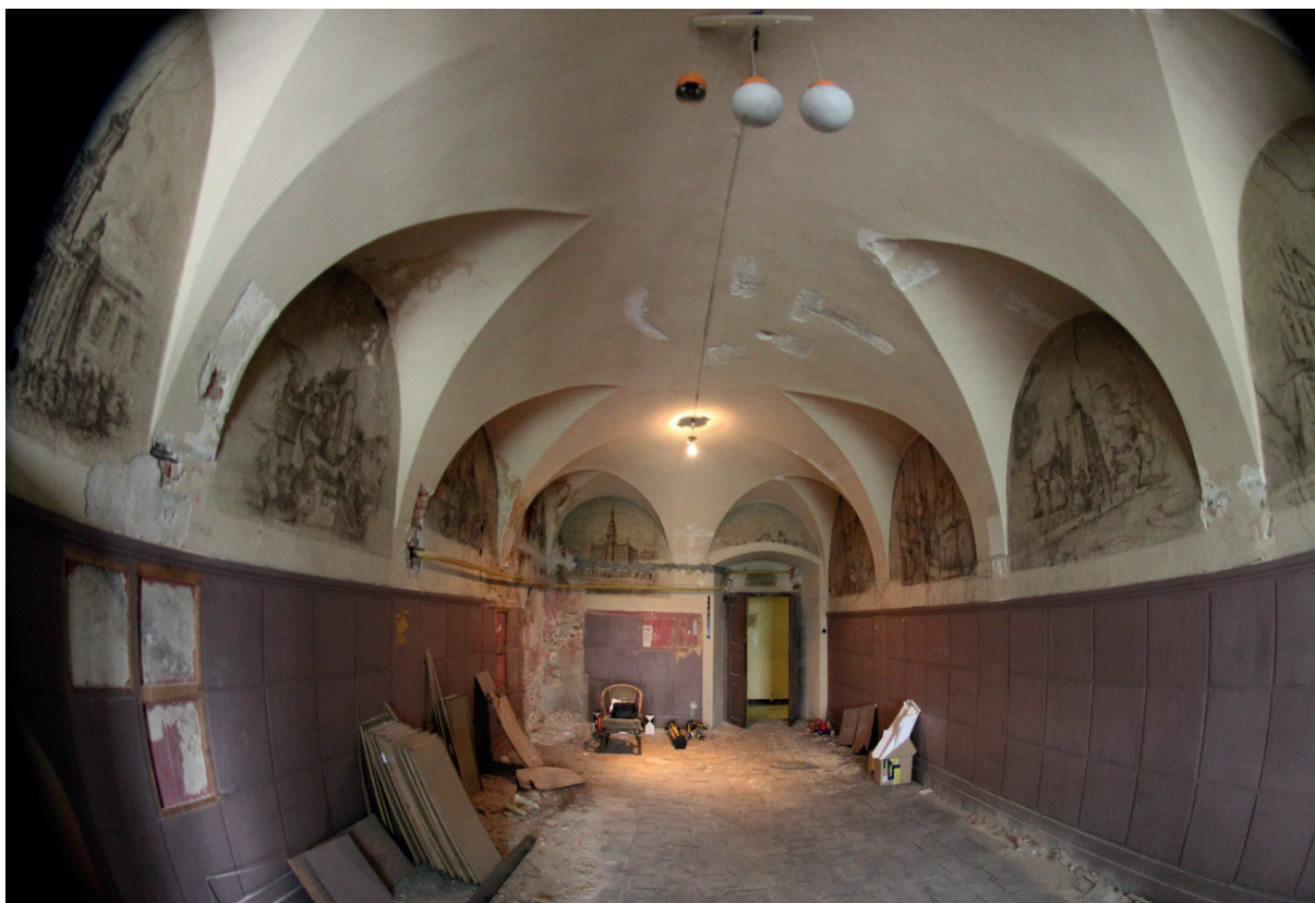
Fot. 25. Pomieszczenie 2.15 w trakcie prac remontowych; fot. K. Janus
