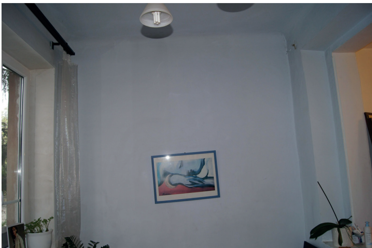
Fot. 23. Pomieszczenie 2.13a (obecnie bez okna i przedzielone ścianką) – powtórzenie ujęcia z ryc. 47; fot. K. Janus
