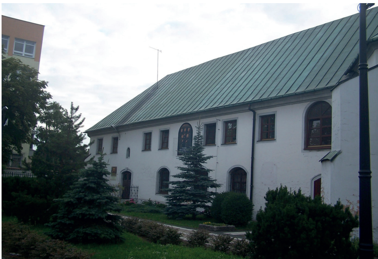
Fot. 8. Budynek klasztoru poreformackiego we Włocławku – 2012 r.; fot. K. Janus
