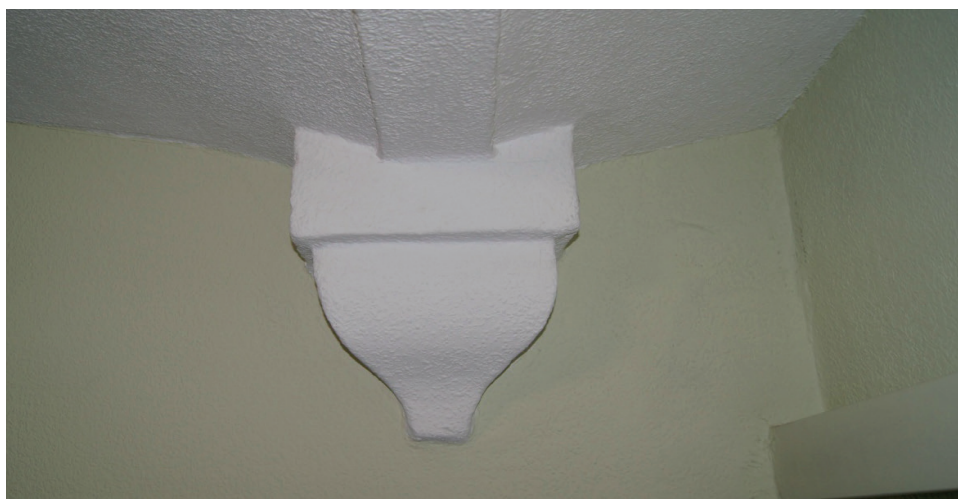
Fot. 29. Wspornik szyny kolejowej stropu odcinkowego nad parterem budynku U; fot. K. Janus
