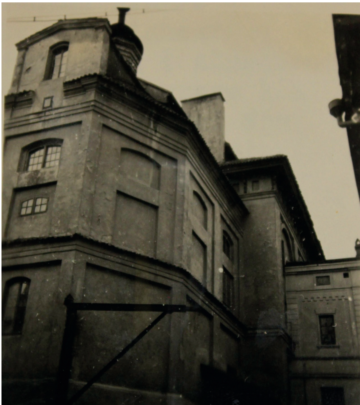
Ryc. 35. Prezbiterium – widok z podwórka, 1937 r.; APL, BGK, sygn. 54, s. 39
