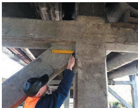
Rysunek 30. Widoki na spód mostu, inwentaryzacja szczegółów architektonicznych: a) boniowanie oraz ślad wody miarodajnej, b) fazowanie krawędzi
