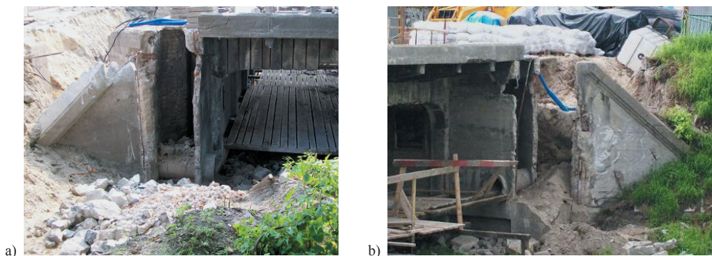
Rysunek 56. Konstrukcja przyczółków mostu: a) od strony ul. 1 Maja, b) od ul. Zamojskiej
