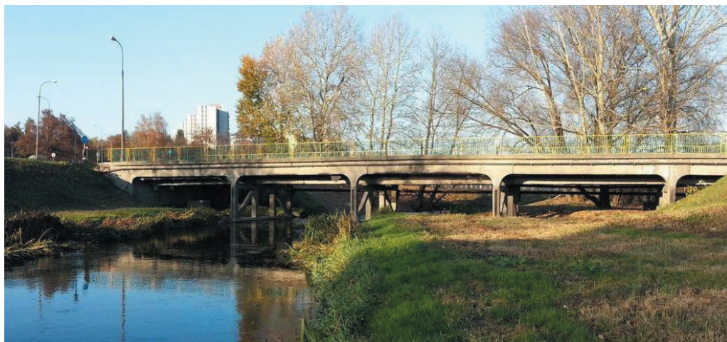
Rysunek 15. Widok mostu na Kalinowszczyźnie od napływu; stan – 2013 r.
