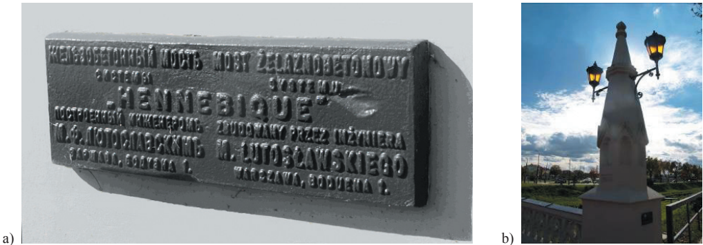
Rysunek 60. Ponownie zainstalowane elementy wyposażenia mostu: a) tablica informacyjna o budownictwie mostu, b) latarnie na fialach
