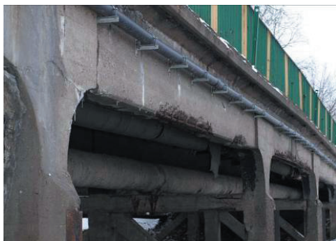
Rysunek 31. Ubytki otuliny betonowej: a) skrajne dźwigary od napływu, b) elementy filarów
