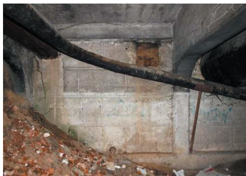
Rysunek 30. Widoki na spód mostu, inwentaryzacja szczegółów architektonicznych: a) boniowanie oraz ślad wody miarodajnej, b) fazowanie krawędzi
