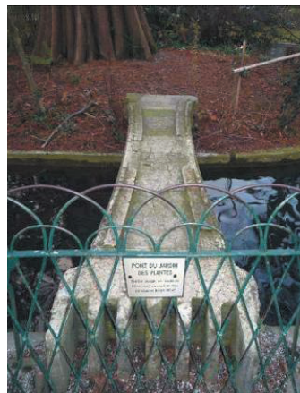
Rysunek 2. Betonowy mostek parkowy w Grenoble (1855) 5 : a) widok z boku, b) widok wzdłuż osi mostu
