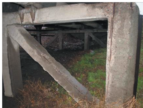
Rysunek 31. Ubytki otuliny betonowej: a) skrajne dźwigary od napływu, b) elementy filarów
