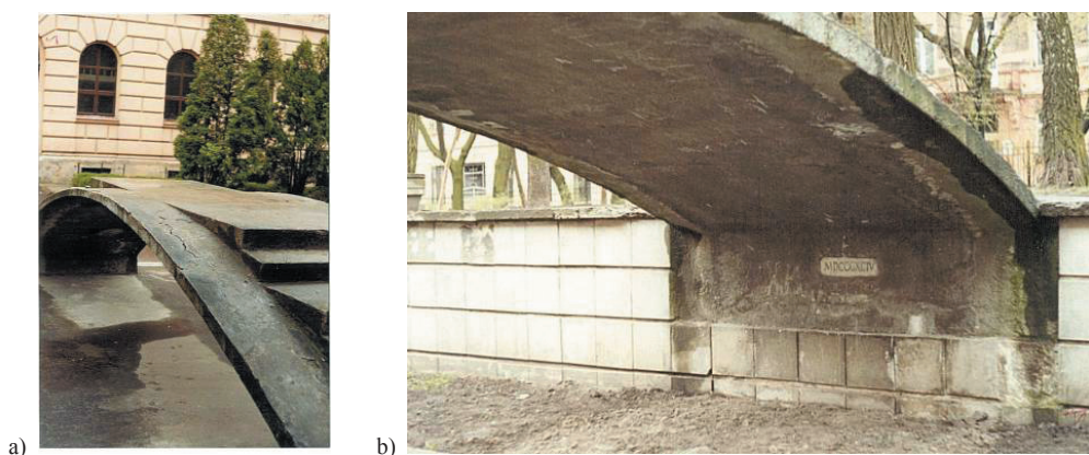
Rysunek 91. Widok na powierzchnie betonowe kładki: a) klucz łuku, b) podparcie łuku, 2001 r.
