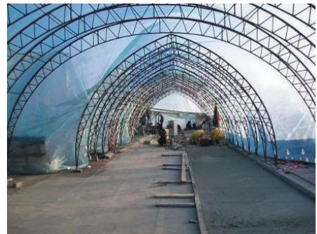
Rysunek 59. Układanie nawierzchni na moście przy niskich temperaturach: a) widok z boku, b) wnętrze namiotu
