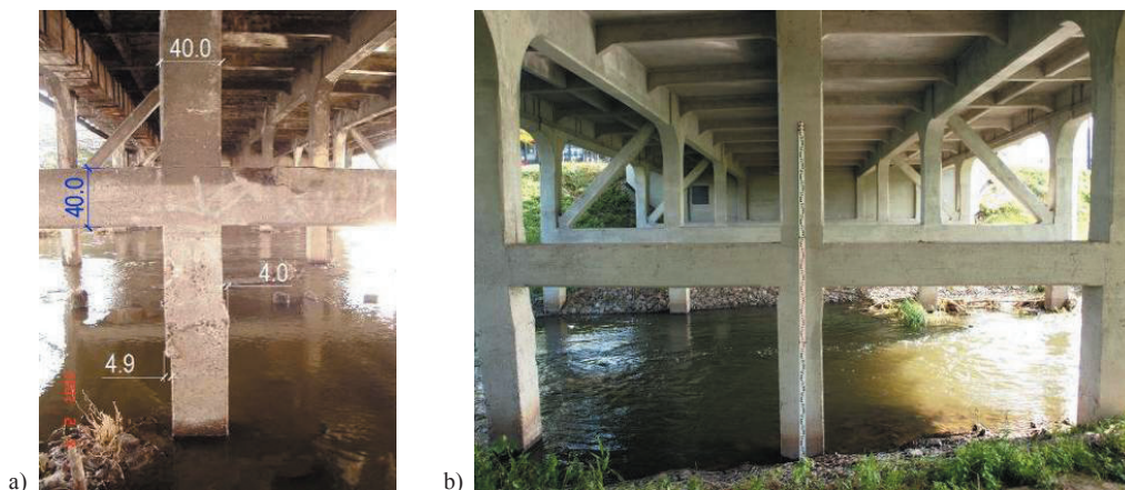
Rysunek 42. Mimośrodowe połączenia pala ze słupem filara: a) rozmiar mimośrodów [cm], b) widok na mimośrodę po remoncie
