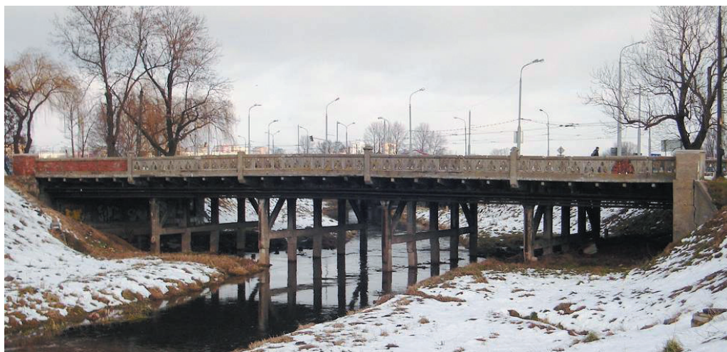
Rysunek 38. Most w ciągu ul. Zamojskiej, stan z 2004 r.
