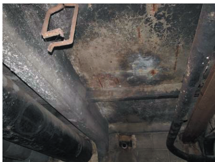
Rysunek 33. Korozja żelbetu belek i płyty pomostu: a) przęsło skrajne od strony Kalinowszczyzny, b) przeciwległe przęsło skrajne
