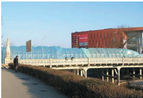
Rysunek 59. Układanie nawierzchni na moście przy niskich temperaturach: a) widok z boku, b) wnętrze namiotu
