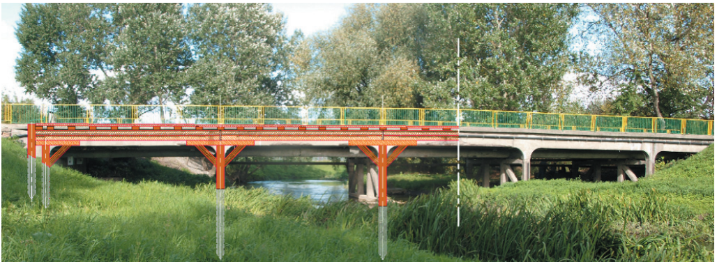
Rysunek 83. Most zastrzałowy z siodełkiem z belką pojedynczą
