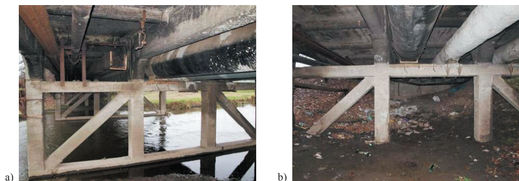
Rysunek 28. Widok od spodu: a) w stronę rzeki, b) w stronę przyczółka od wschodu
