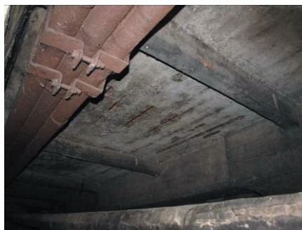
Rysunek 33. Korozja żelbetu belek i płyty pomostu: a) przęsło skrajne od strony Kalinowszczyzny, b) przeciwległe przęsło skrajne
