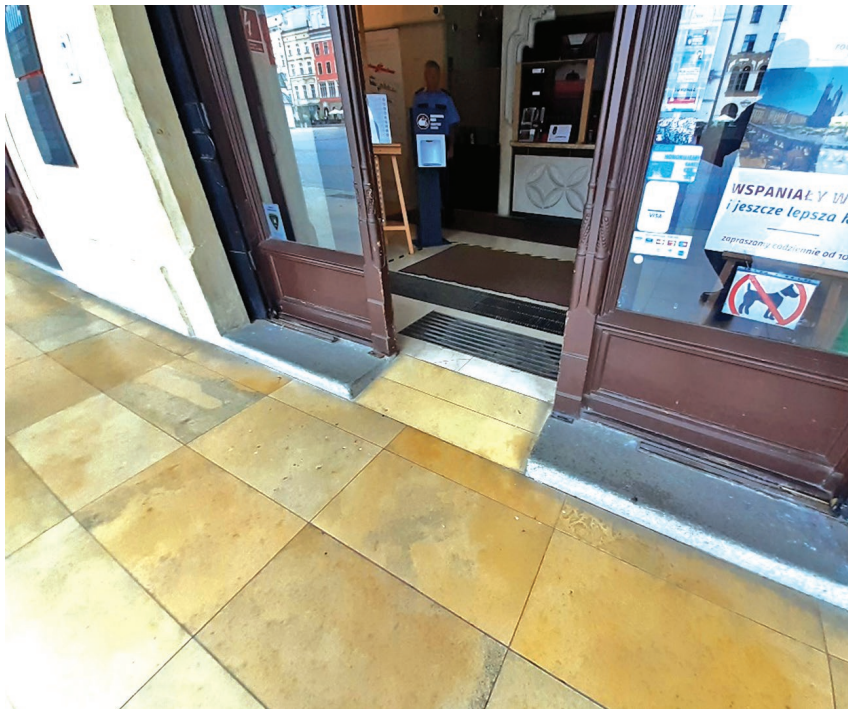
Fragment płyty tworzącej próg w drzwiach wejściowych do Galerii Sztuki Polskiej XIX wieku w Sukiennicach został usunięty
