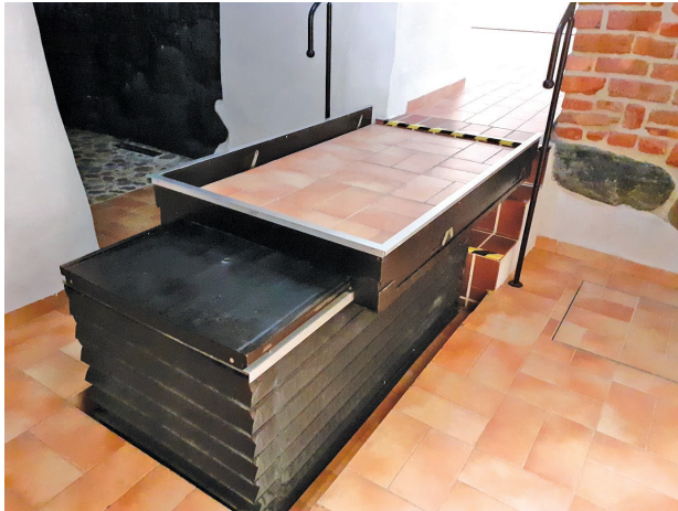
Platforma podnośnika dosuwa się do krawędzi posadzki na wyższym poziomie
