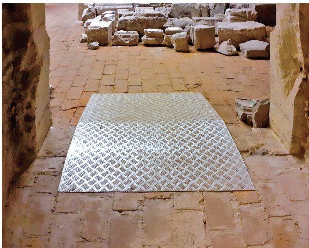
Zamek Królewski na Wawelu – blaszane elementy niwelujące progi pomiędzy pomieszczeniami, w których zorganizowano lapidarium
