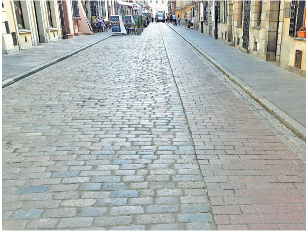
Pas równiejszej nawierzchni położony na pokrytej brukiem ulicy Piwnej
