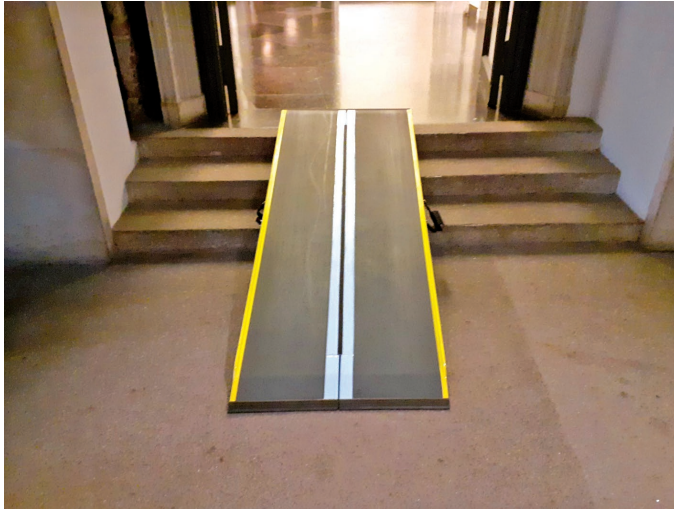
Rozkładany podest zapewniający dostępność jednej z sal ekspozycji Wawel Zaginiony
