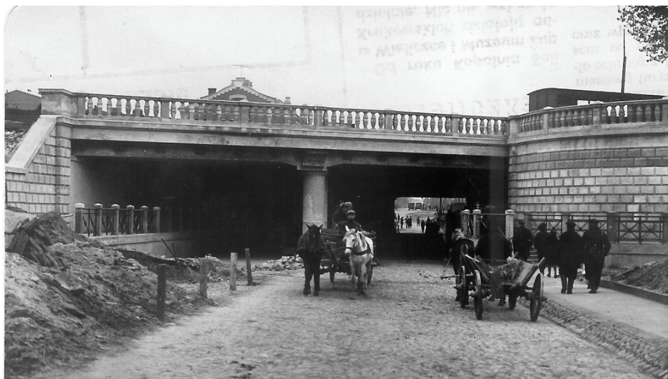
Ryc. 117. Wiadukt kolejowy na ul. Bychawskiej w znaczny sposób przyczynił się do zwiększenia bezpieczeństwa przejazdu, usprawnienia komunikacji, a w konsekwencji do szybszego rozwoju południowej części Lublina. Architektura budowli nawiązuje do stylu narodowego. Fotografia z lat 30. XX w., własność Teatr NN
