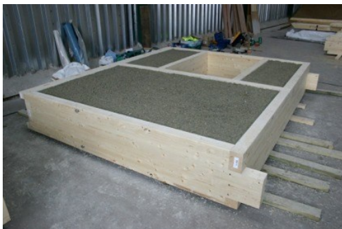
Rys. 5.27. Segment ścienny z wykonanym otworem drzwiowym [www.the-self-build-guide.co.uk]
