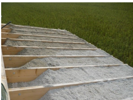
Rys. 5.29. Izolacja dachu w postaci luźnej, lekkiej mieszanki wapienno-konopnej [P. Brzyski]
