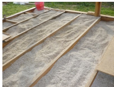
Rys. 5.32. Izolacja mieszanką wapienno-konopną podłogi o konstrukcji legarowej uniesionej ponad gruntem na fundamentach punktowych [P. Brzyski]
