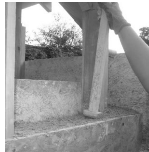
Rys. 12.7. Kierunek zagęszczania mieszanki w deskowaniu ściennym [P. Brzyski]
