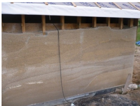
Rys. 5.18. Uzyskana faktura ściany z kompozytu wapienno-konopnego, świadcząca o niejednorodności paździerzy konopnych [P. Brzyski]
