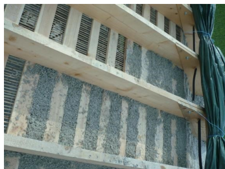
Rys. 5.30. Zagęszczona warstwa kompozytu wapienno-konopnego stanowiąca zaślepienie szczelin pomiędzy żdźbłami trzciny [P. Brzyski]
