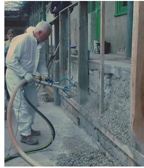
Rys. 5.22. Mechaniczny natrysk mieszanki wapienno-konopnej na mur ceglany [P. Brzyski]
