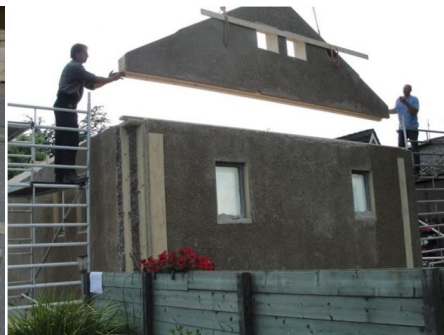
Rys. 5.28. Montaż segmentów ściennych [www.dunagroheimgroup.nl]
