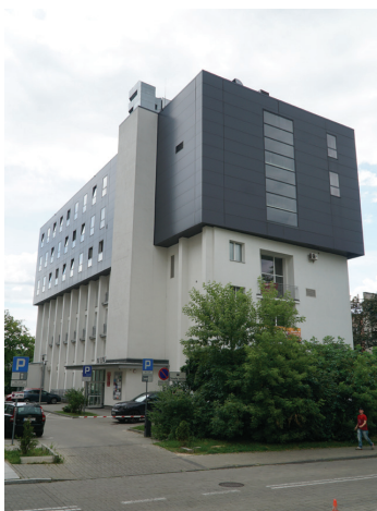
Dom Technika po nadbudowie trzech pięter (właściciel spółka zewnętrzna). Fot. Benon Bujnowski
