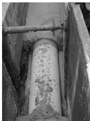
Rys. 2. Zalewanie przewodu kanalizacyjnego upłynnionym gruncem.
