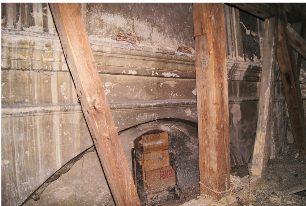
Il. 246. Poziom poddasza ponad kruchtą kościoła pobernardyńskiego, widok na zabudowaną w XIX w. elewację, fot. K. Janus, 2012 r.
