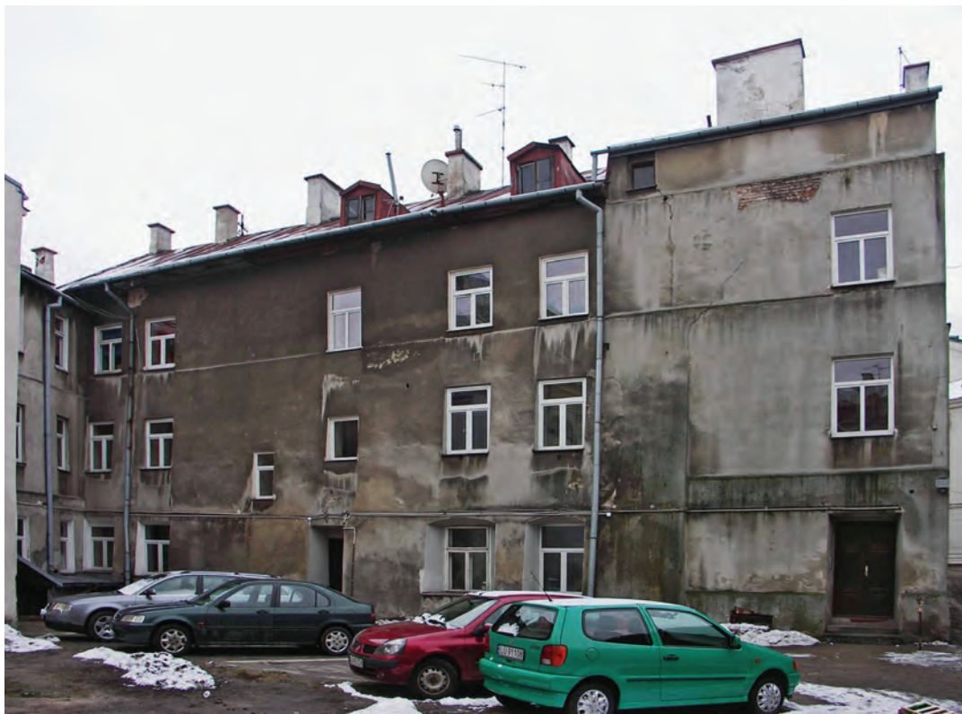
Il. 92. Elewacja tylna kamienicy Bernardyńska 12, fot. K. Janus, 2015 r.
