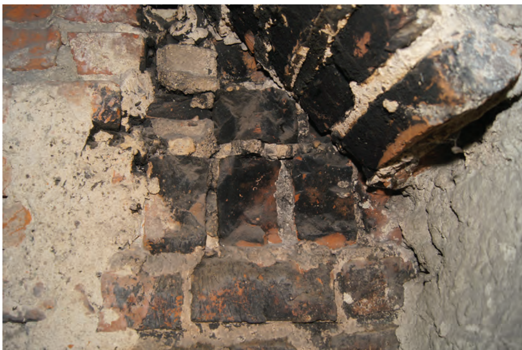
Il. 250. Wieża zegarowa klasztoru pobernardyńskiego, ślady pożaru widoczne na gzymsie i łąku, fot. K. Janus, 2012 r.
