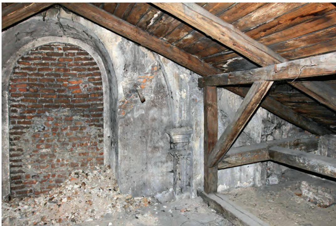
Il. 361. Elewacja południowa nawy kościoła z zachowanym tynkiem, gzymsami i oryginalnym kształtem otworu okiennego z pierwszej fazy budowy kościoła, w skrajnych częściach widoczny odcisk (negatyw) starszego dachu (prawdopodobnie sprzed pożaru z 1720 r.), fot. K. Janus, 2017 r.
