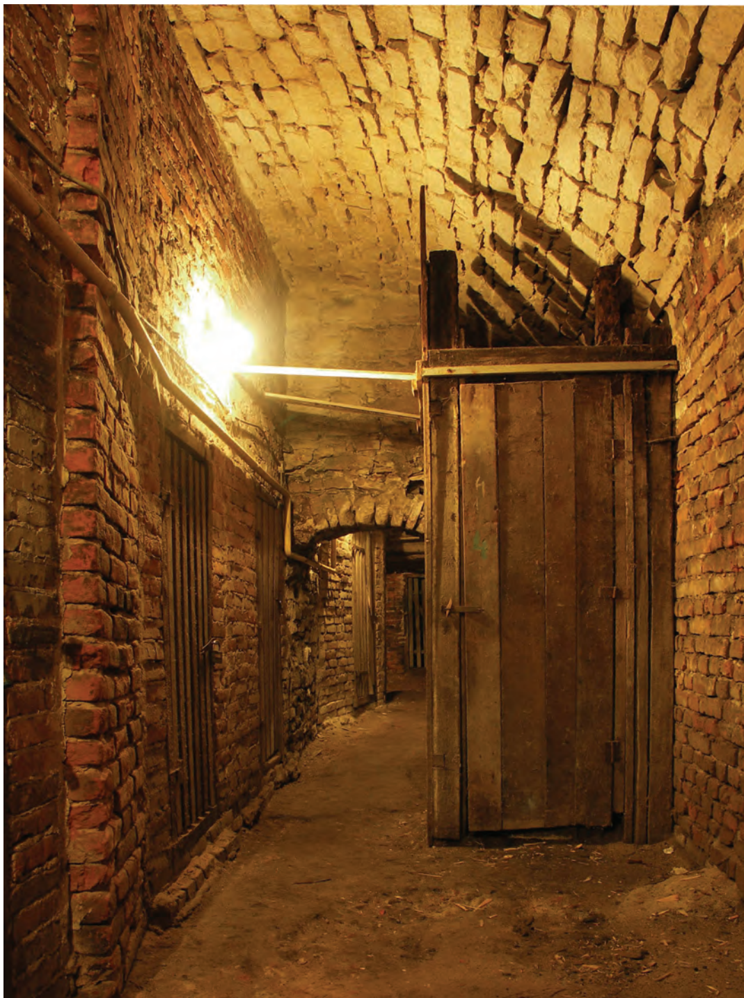
Il. 94. Piwnica kamienicy Bernardyńska 12, widok ogólny, fot. K. Janus, 2011 r.
