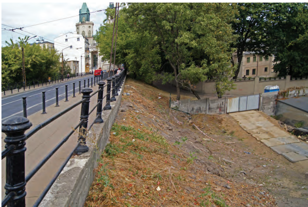
Il. 419. Ulica Wyszyńskiego, widok w kierunku północnym, widoczna różnica wysokości pomiędzy poziomem nawierzchni ulicy (po lewej) a poziomem podwórka posesji przy ul. Misjonarskiej (po prawej) przed wykonaniem muru oporowego, fot. K. Janus, 2016 r.
