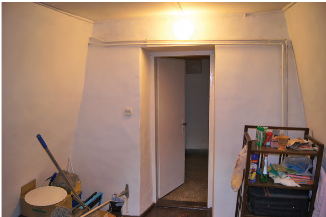
Il. 239. I piętro, pomieszczenie z przerobionego komina butelkowego (2.49) , fot. K. Janus, 2012 r.
