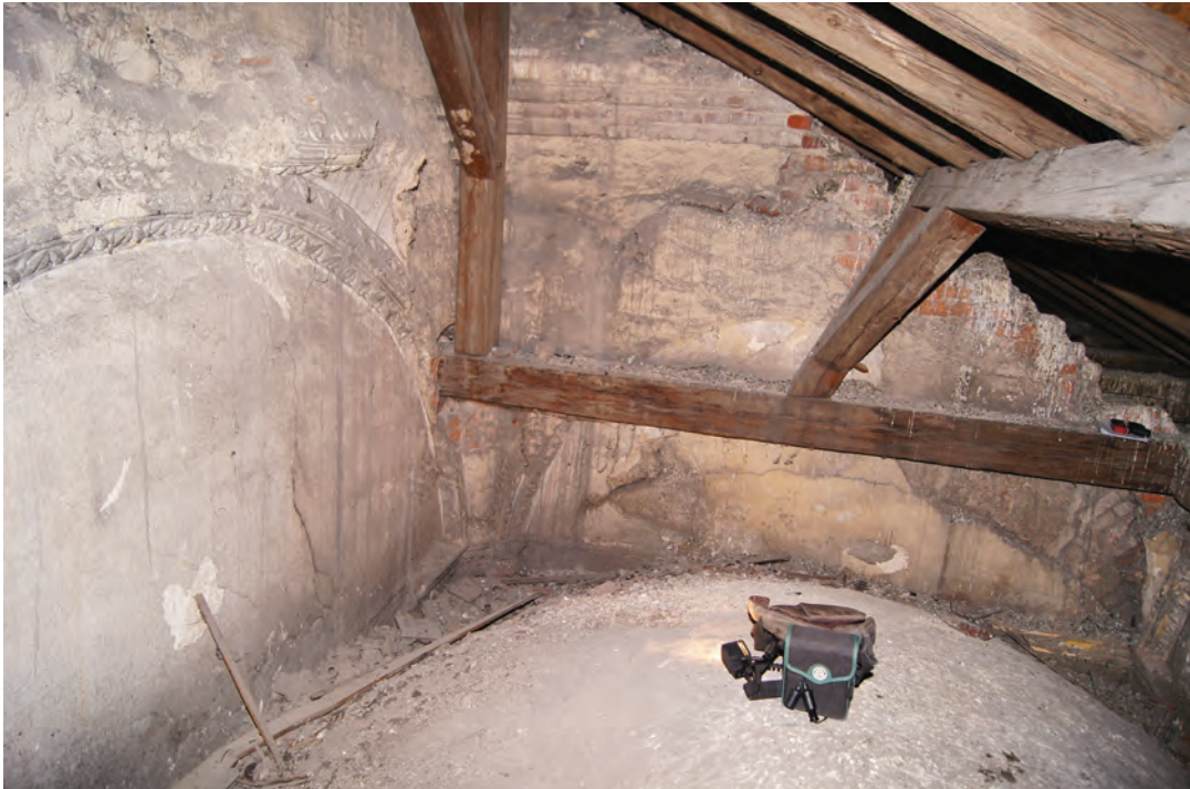
Il. 243. Poddasze nad nawą południową kościoła pobernardyńskiego, widok na pierwotną ścianę fasady. Po lewej widoczne pole tarczowe ze zdobieniem kopuły/sklepienia nieistniejącej wieży, na wprost gzyms koronujący fasadę kościoła z pierwszej fazy renesansowej, fot. K. Janus, 2012 r.
