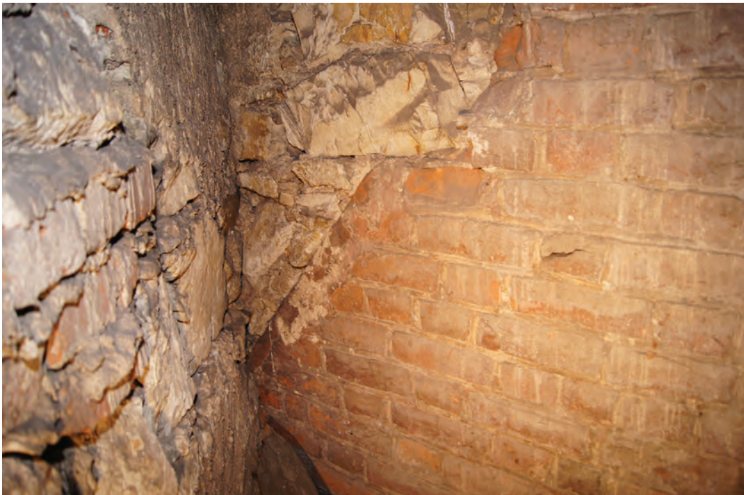
Il. 247. Poddasze ponad przejściem z nawy bocznej do kaplicy kościoła pobernardyńskiego, widok na ścianę wschodnią z zachowaną przyporą z cegieł gotyckich, fot. K. Janus, 2012 r.
