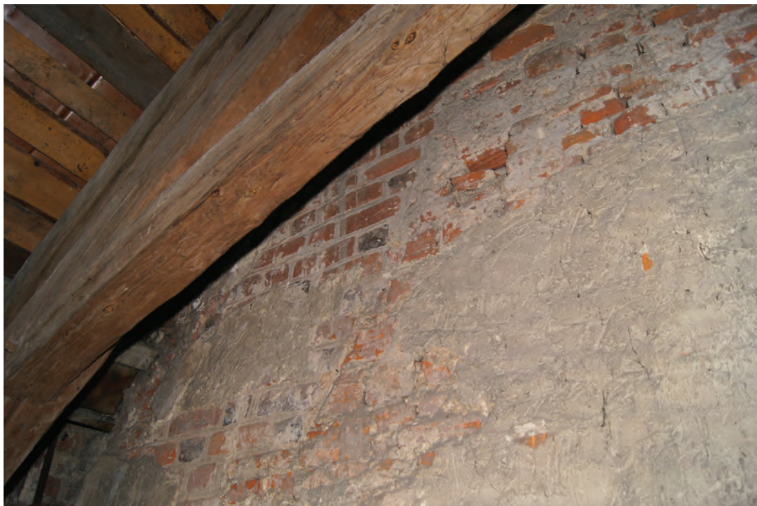
Il. 241. Poddasze nad prezbiterium kościoła pobernardyńskiego, widok na ścianę tęczy, miejsce połączenia dwóch murów, fot. K. Janus, 2012 r.
