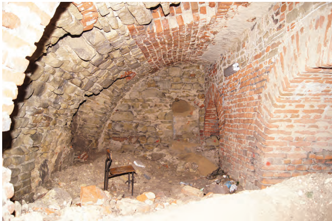
Il. 228. Piwnica pod podwórkiem klasztoru pobernardyńskiego, pomieszczenie 0.06, widok na ścianę północną, po prawej ściana wzmacniająca sklepienie, na którym posadowiona jest ściana wschodnia skrzydła zachodniego klasztoru, fot. K. Janus, 2012 r.
