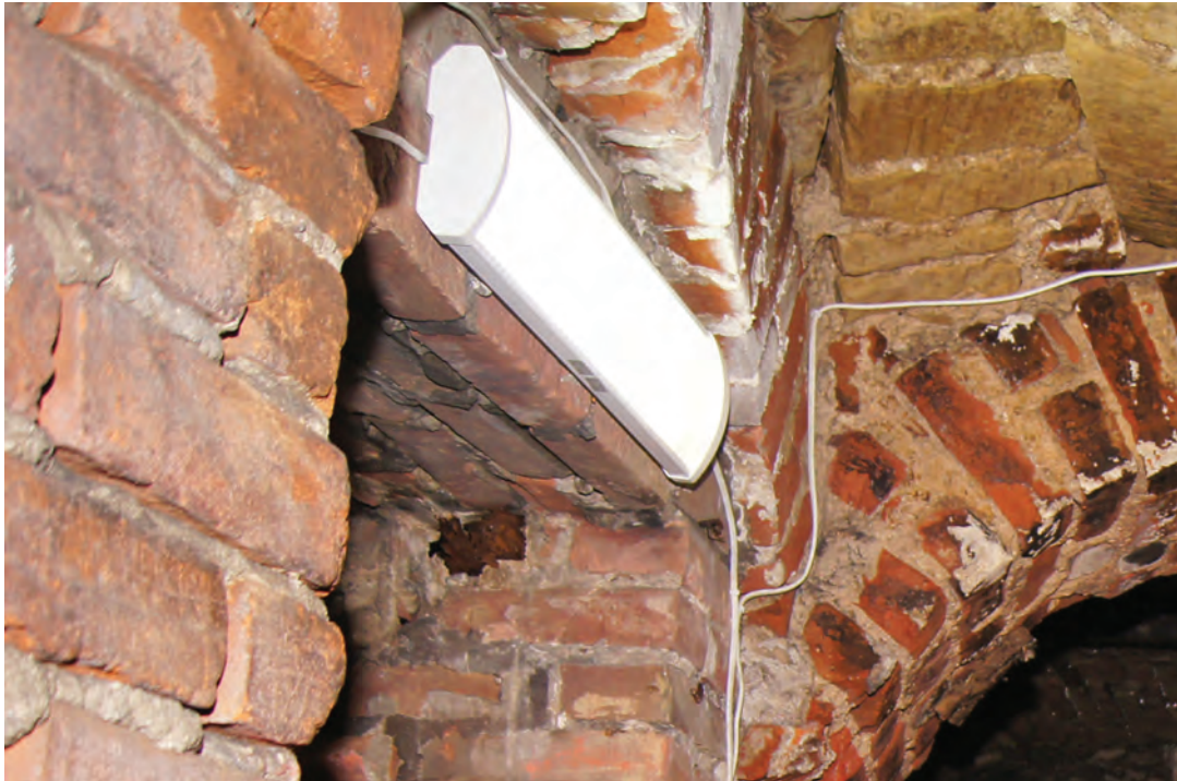
Il. 227. Piwnica, fragment ostrołukowego sklepienia, wykonanego z cegieł „gotyckich”, prowadzącego do pomieszczenia 0.06, fot. K. Janus, 2012 r.
