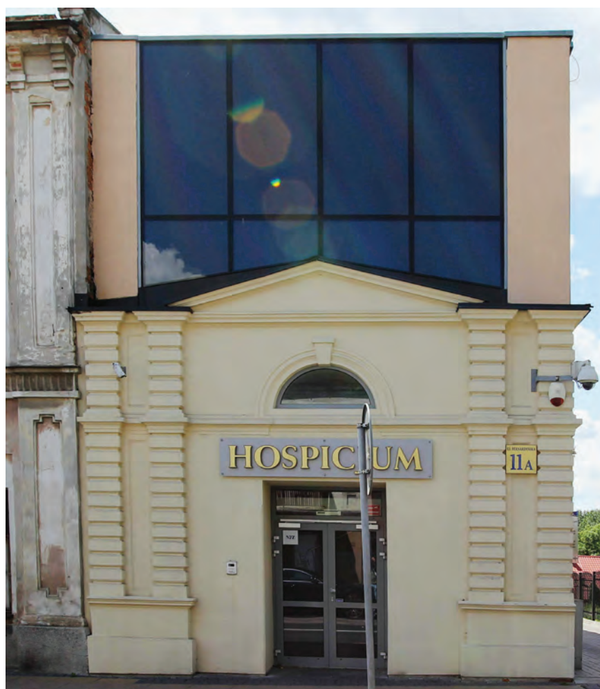
Il. 280. Budynek Bernardyńska 11a, elewacja frontowa, fot. K. Janus, 2017 r.
