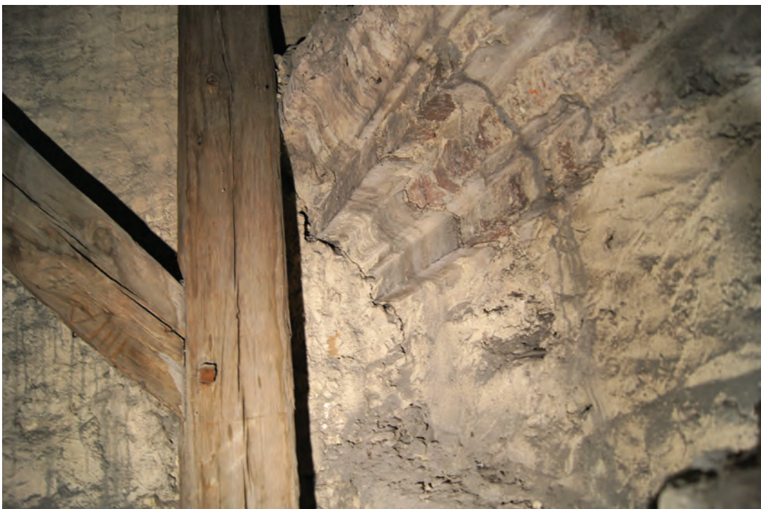
Il. 244. Poziom poddasza ponad nawą południową kościoła pobernardyńskiego, widok na gzyms pierwotnej fasady, fot. K. Janus, 2012 r.
