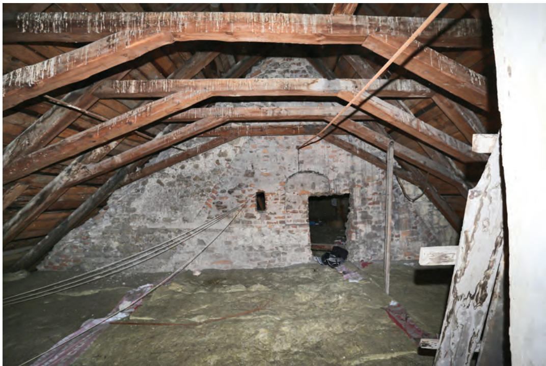
Il. 251. Poddasze nad aneksem wschodnim klasztoru pobernardyńskiego, z widocznym kształtem starszego szczytu, fot. K. Janus, 2012 r.
