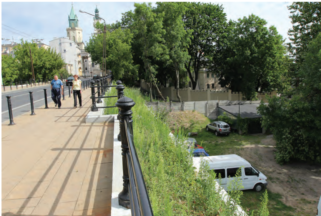
Il. 418. Ulica Wyszyńskiego, widok w kierunku północnym, widoczna różnica wysokości pomiędzy poziomem nawierzchni ulicy (po lewej) a poziomem podwórka posesji przy ul. Misjonarskiej (po prawej) – 2017 r. po wykonaniu muru oporowego, fot. K. Janus, 2017 r.
