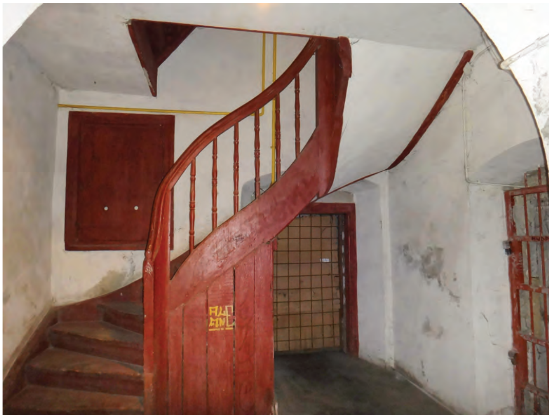
Il. 169. Kamienica Bernardyńska 20, klatka schodowa w sieni, fot. K. Janus, 2017 r.
