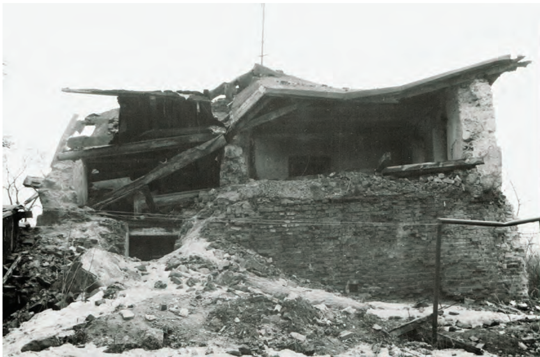
Il. 213. „Dom pod Orłem”, widok na elewację północną, A. Kasiborski, 1988 r, Archiwum LWKZ, sygn. 1970P
