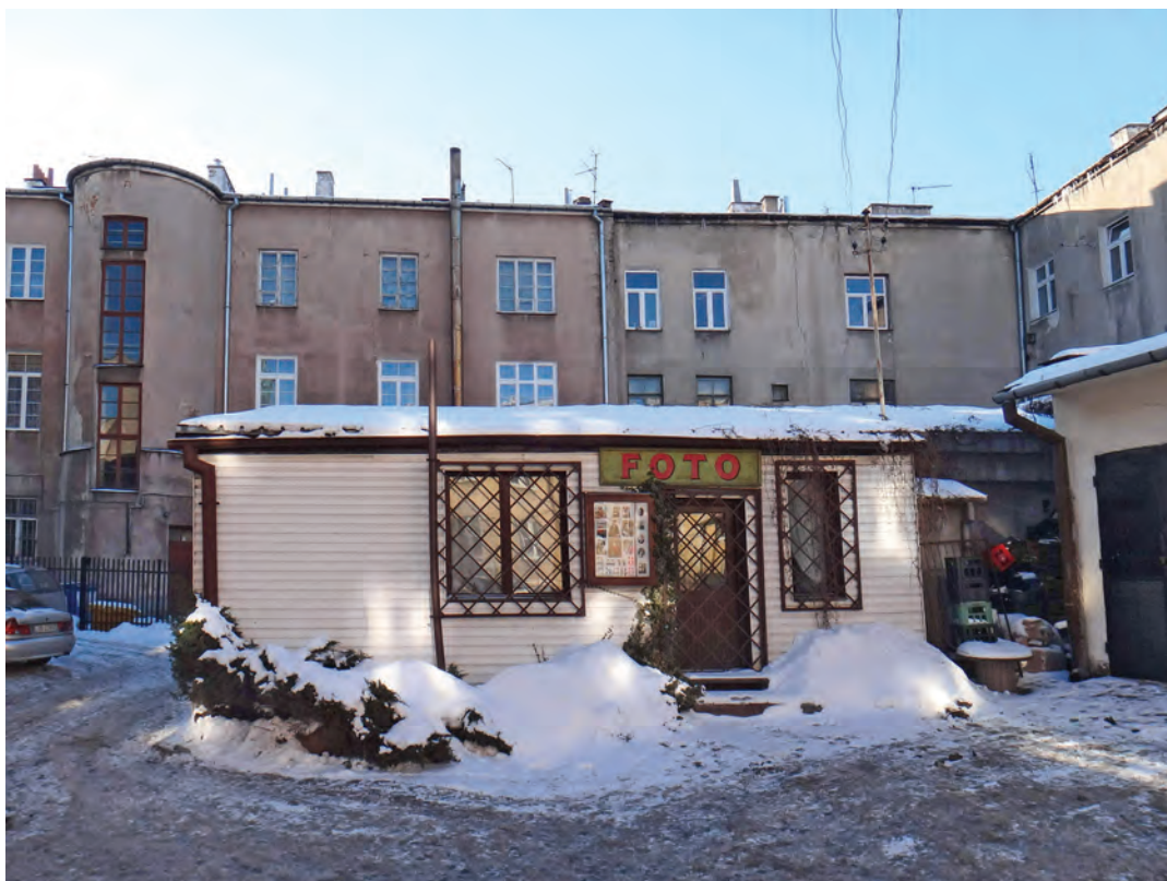
Il. 62. Elewacja tylna kamienicy Bernardyńska 8, fot. K. Janus, 2017 r.
