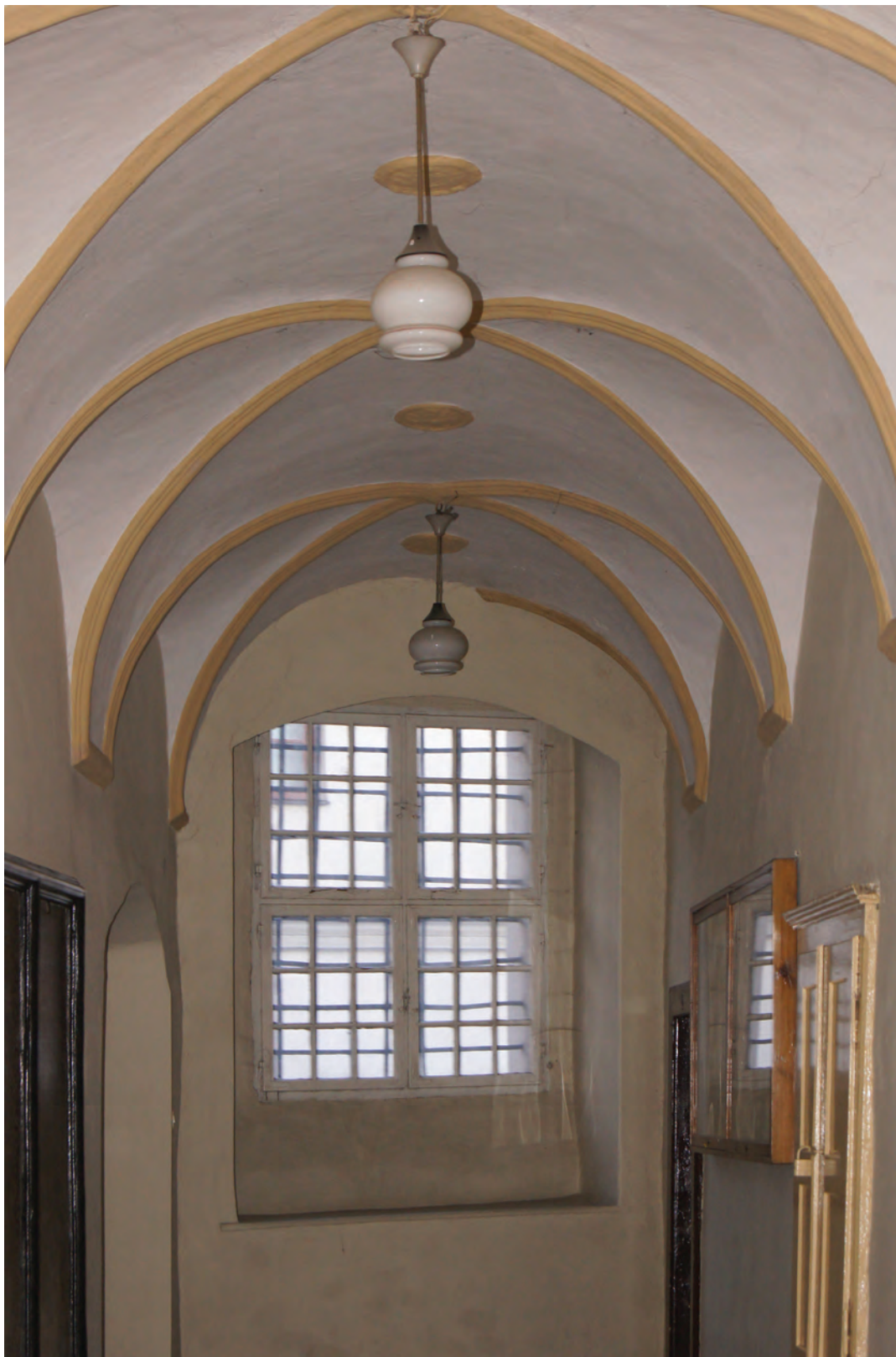
Il. 235. Parter klasztoru pobernardyńskiego, korytarz przy prezbiterium, widok na ścianę wschodnią, fot. K. Janus, 2012 r.
