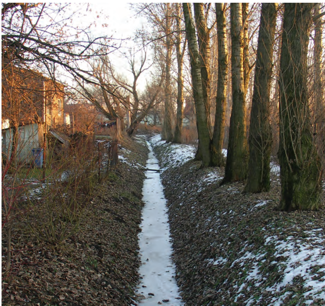
Il. 413. Rów melioracyjny, biegnący prawdopodobnie po starym „dawnym kanale zamkowym”, fot. K. Janus, 2008 r.
