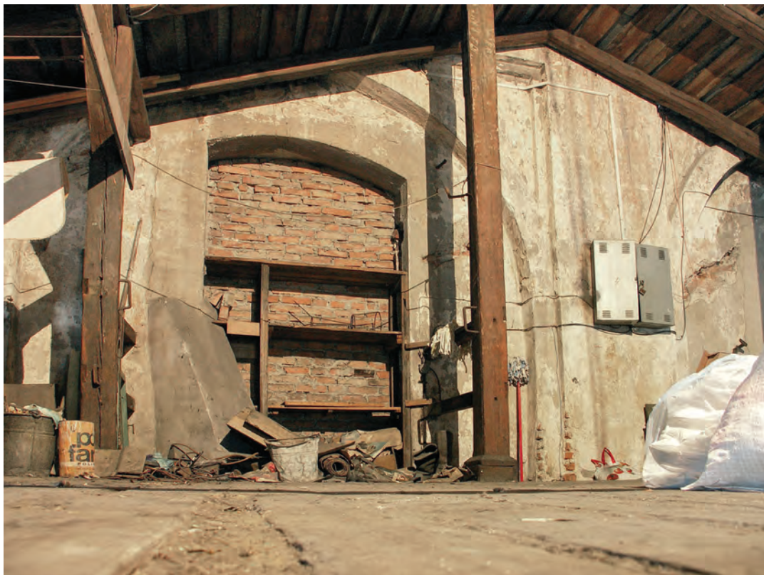
Il. 360. Poddasze – widoczna elewacja północna kościoła, która została zasłonięta po wykonaniu dachu budynku w 1910 r., fot. K. Janus, 2017 r.
