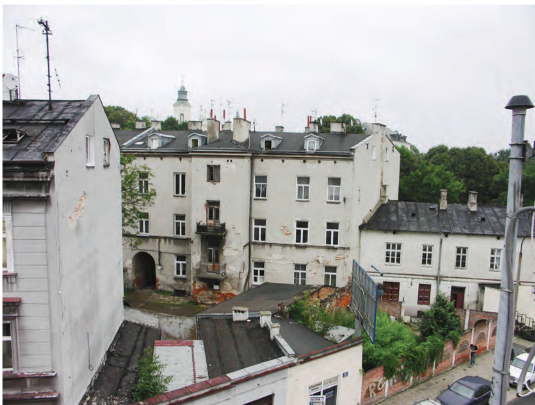
Il. 195. Niezabudowana część pomiędzy kamienicą 26 a 28, fot. K. Janus, 2017 r.
