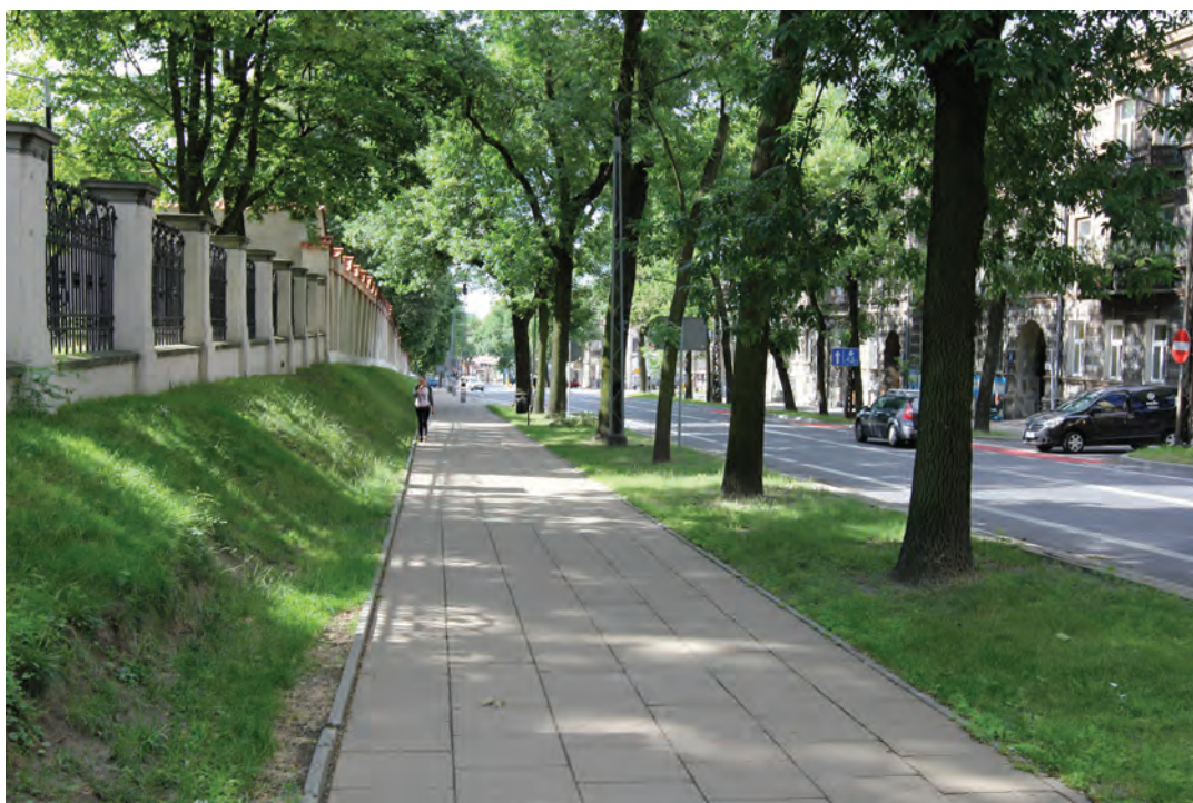
Il. 417. Ulica Wyszyńskiego, widok w kierunku południowym, po lewej widoczna skarpa, wyznaczająca pierwotne ukształtowanie wzgórza Żmigród ścięta w trakcie wykonywania ulicy Zamojskiej, fot. K. Janus, 2017 r.
