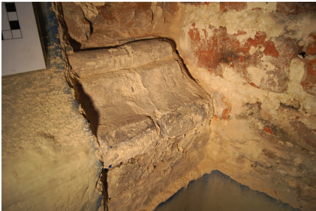
Il. 237. Parter, pomieszczenia wieży klasztoru pobernardyńskiego, fragment zwieńczenia cokołu profilem kamiennym, fot. K. Janus, 2012 r.
