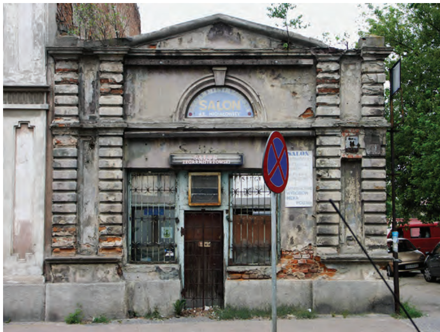
Il. 279. Budynek Bernardyńska 11a, elewacja frontowa, fot. K. Janus, 2010 r.
