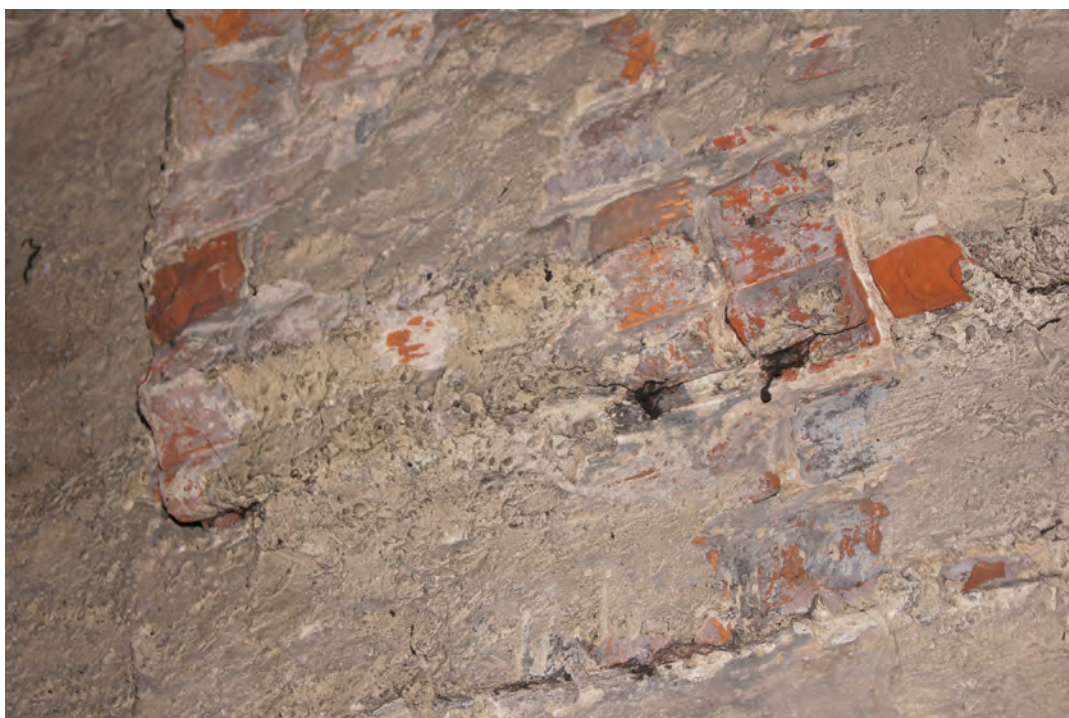
Il. 242. Południowa ściana prezbiterium kościoła pobernardyńskiego, widok z poddasza nad klasztorem, profilowane kształtki ceglane gzymsu kościoła z najstarszej fazy, fot. K. Janus, 2012 r.
