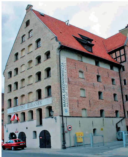
Ryc. 3. Gdańsk Chmielna 53. Spichlerz Błękitny Baranek. Fragment elewacji. Stan po pracach konserwatorsko-restauratorskich. Fot. K. Szczepanowska.
