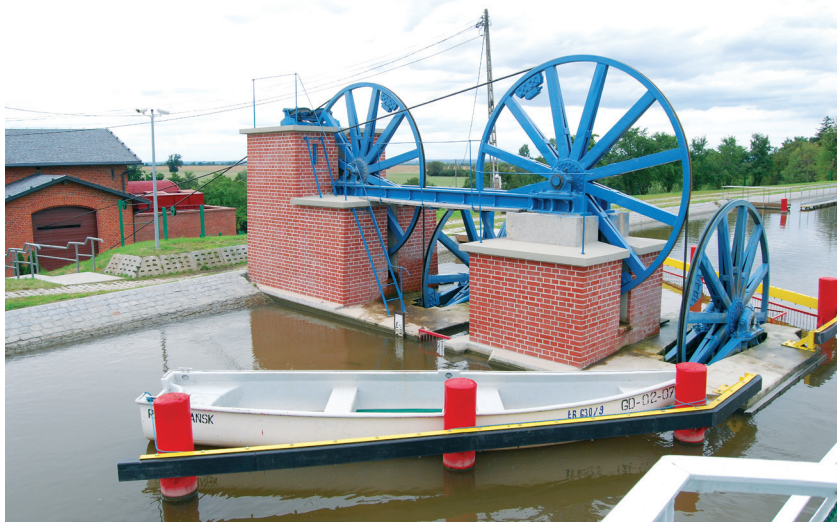
5. The Elbląg Canal, ramp. Photo: J. Lewicki, 2016.
