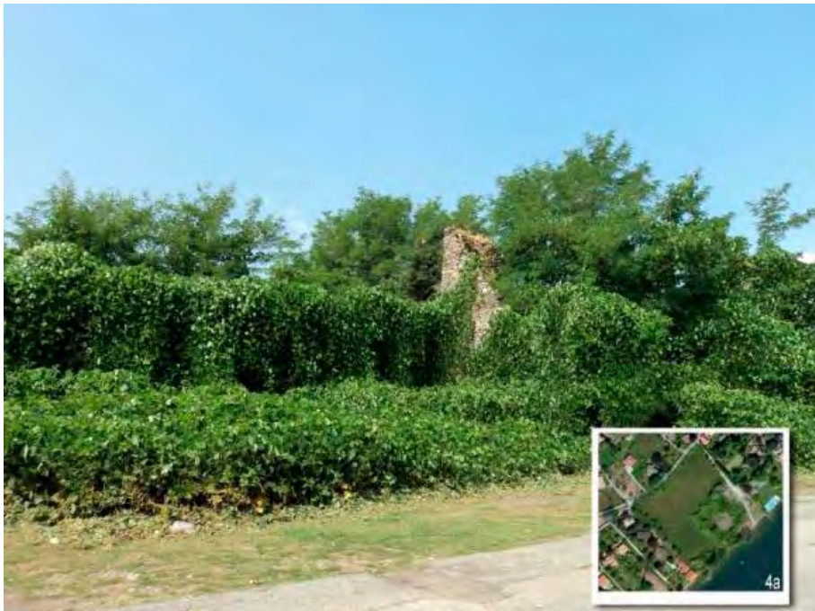
Fig. 35. Castle of Lesa (NO), fortified wall - source: Bartolozzi, C. and Novelli, F., Resti e ruderi di strutture fortificate in provincia di Novara: studi per una strategia di conservazione e valorizzazione, p. 115.
