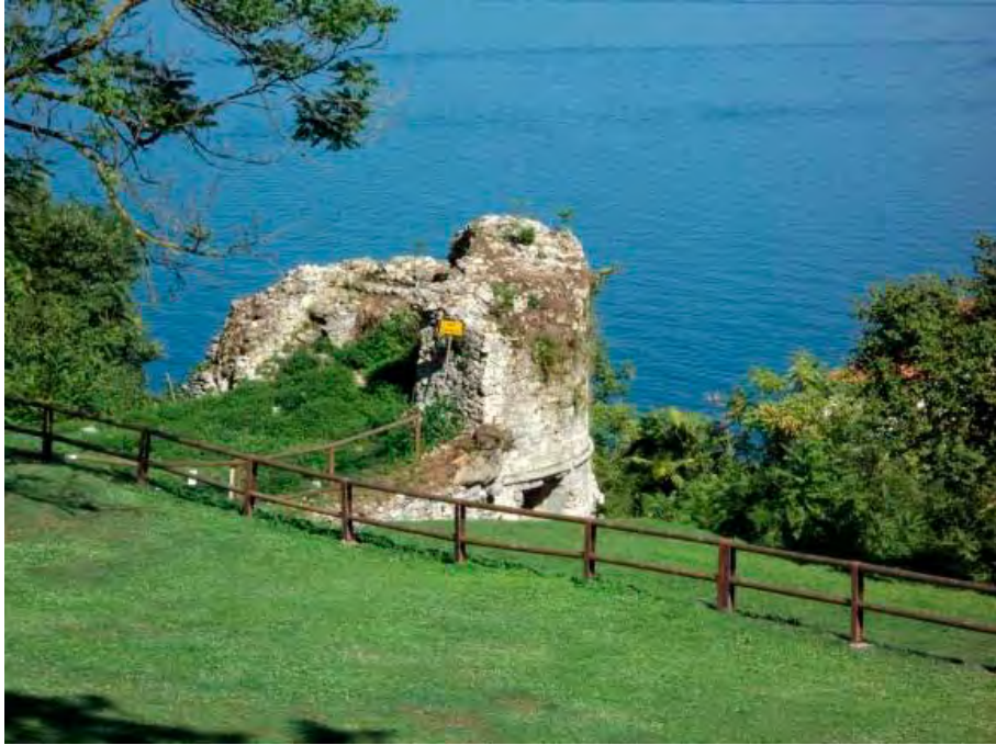
Fig. 34. Sordinesca Tower (ruins) in Rocca Borromea Park, Arona (NO) - Source: Bartolozzi, C. and Novelli, F., Resti e ruderi di strutture fortificate in provincia di Novara: studi per una strategia di conservazione e valorizzazione, p. 115.
