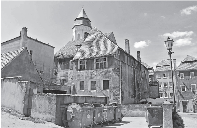
Fot. 13. Kozuchów, zabudowa na tyłach kamienic w północnej części starego rynku
