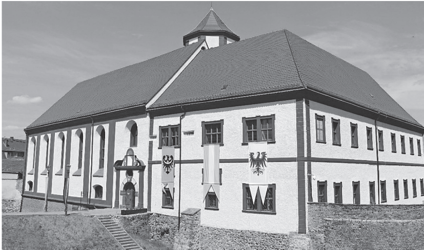
Fot. 2. Koźuchów, zamek, widok od południowego wschodu
