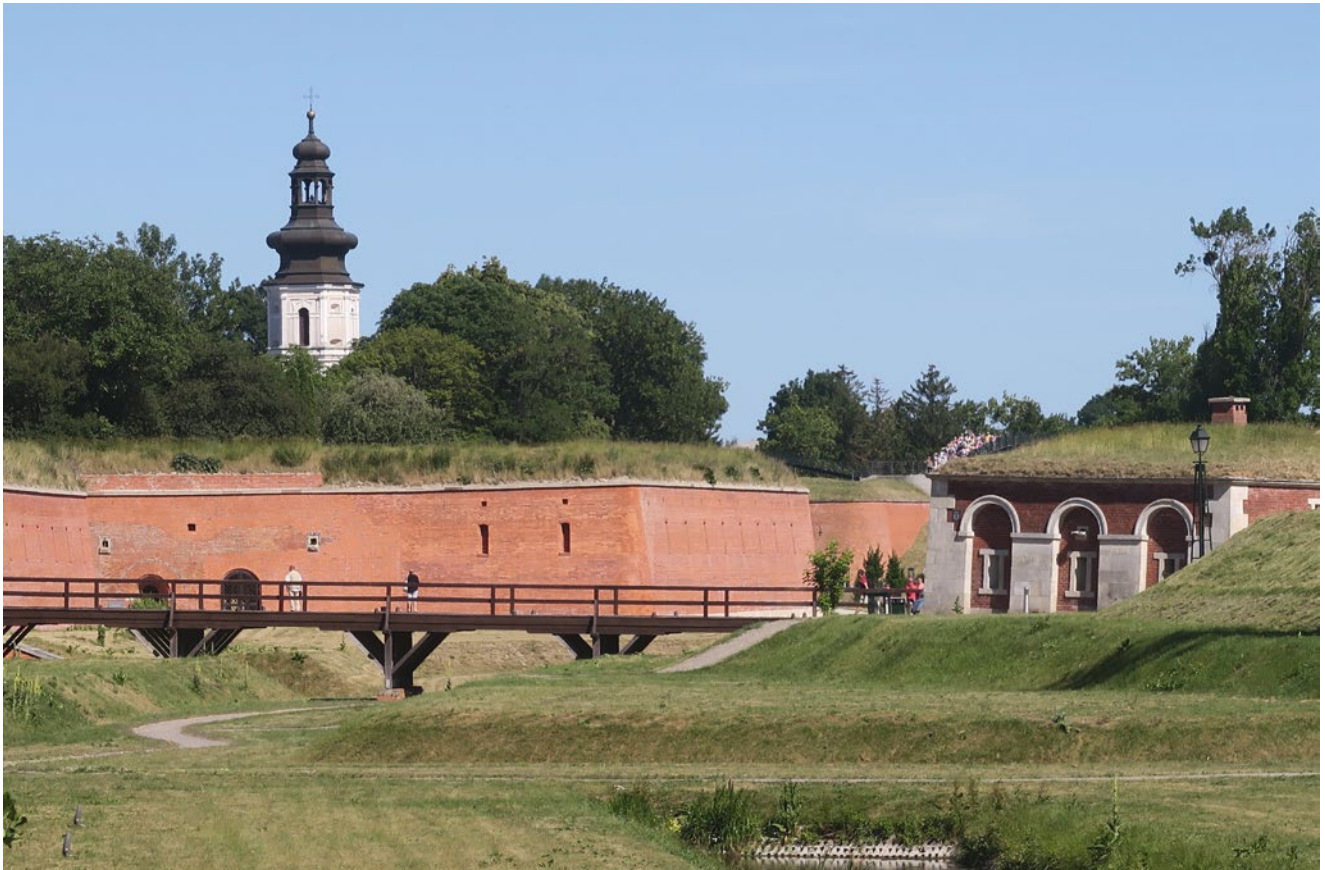
Przeplatanie się form ziemnych, murowanych i ceglano – ziemnych tworzy charakterystyczny labirynt dzieł obronnych w obwodzie warownym Zamościa (fot. A. Siwek)
