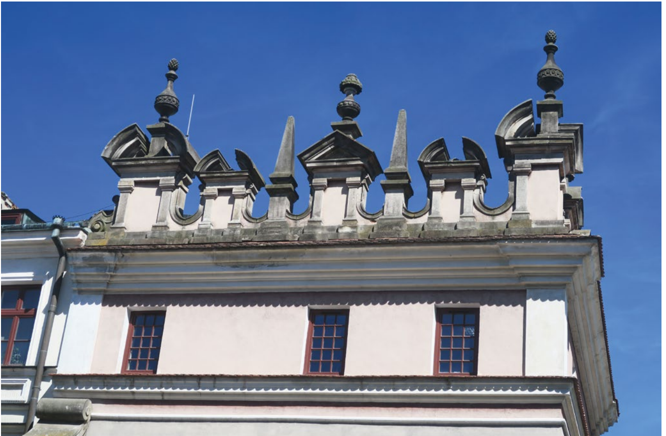
Detal architektoniczny – atyka kamienicy przy ul. Kolegiackiej - rekonstrukcja z 1978 r., według rysunku E. Andriollego, proj. G. Zamojski, H. Kossuth. Cenny zabytek ilustrujący koncepcje konserwatorskie 2 połowy XX w. (A. Siwek)
