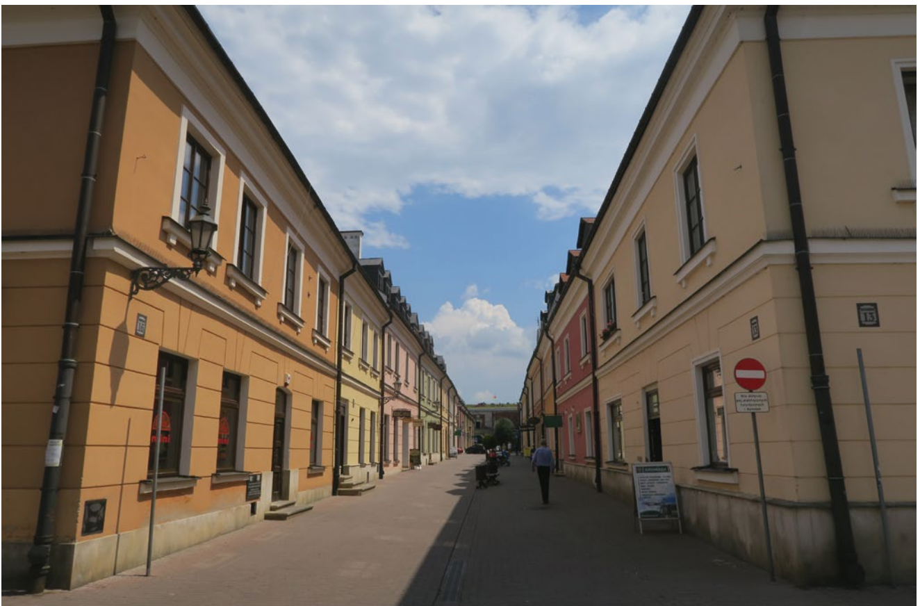
Charakterystyczny rytm, gabaryt i formy zabudowy historycznego układu urbanistycznego Zamościa (fot. A. Siwek)
