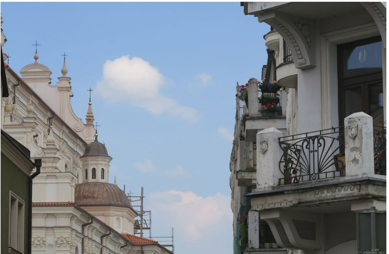
Nawarstwienia historyczne i ingerencje konserwatorskie w krajobrazie miasta. Bryła kościoła franciszkanów z lat 1637 – 1665, współczesna (2014 – 2020) rekonstrukcja fasady, szczytów i kaplic zniszczonych w XIX w. oraz detal sąsiadującej z kościołem kamienicy z ok. 1900 r. z secesyjnym ornamentem (fot. A. Siwek)
