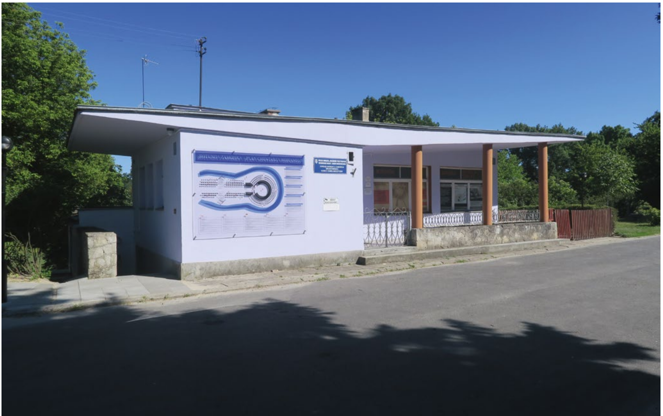
Pawilon przy wejściu na teren cmentarza wojennego Rotunda, lata 60. XX w. Kameralne dzieło architektury modernistycznej. Przykład dobra kultury współczesnej, które uzyskuje wartość i charakter obiektu zabytkowego, jako reprezentatywny przykład budowli o czytelnych cechach stylowych, charakterystycznych dla minionej epoki historycznej. (fot. A. Siwek)
