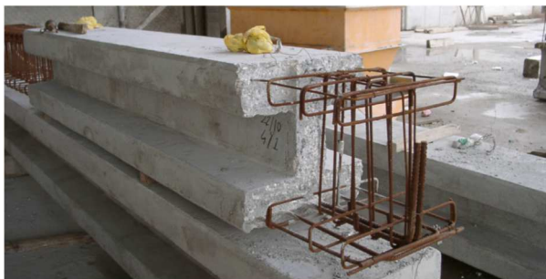
Rys. 2.30. Widok belki przygotowanej do zespolenia z poprzeczną przerwą roboczą (Cavaco, 2017)
