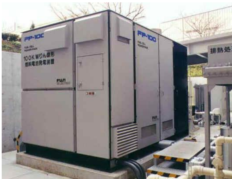
Rys. 3. Wykorzystanie ogniwa typu PAFC w Fuji-Electric o mocy 100 kW [2]
