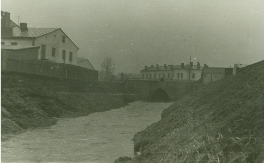
Rys. 85. Wylot rzeki Czechówki z przesklepienia, autor nieznanym, Archiwum Państwowe w Lublinie, wg [78]
