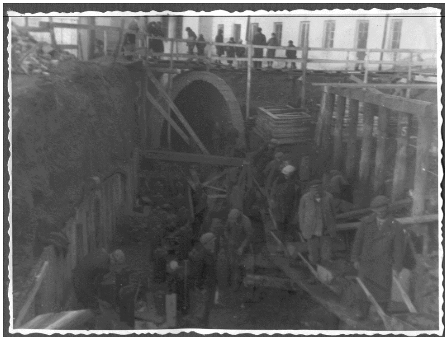
Rys. 81. Wykonany i obsypany odcinek przesklepienia od rozebranego mostu między ul. Jateczną i ul. Sienną. Widok w kierunku ul. Mostowej. Po prawej budynek przy ul. Siennej 2. Autor nieznany, Kolekcja Jolanty i Wojciecha Jurkiewiczów, 1937
