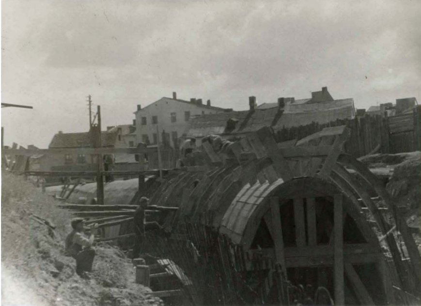
Rys. 89. Szalowanie III etapu. Prace zbliżają się do ul. Lubartowskiej. Autor nieznany, Archiwum Państwowe w Lublinie, wg [86]
