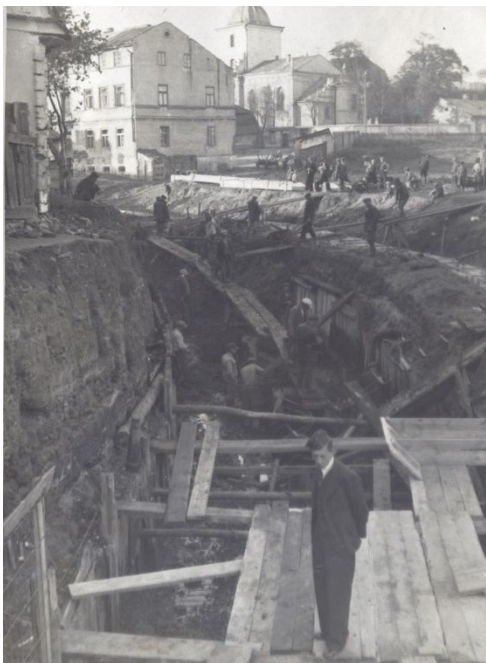
Rys. 77. Budowa przesklepienia na zakolu Czechówki pomiędzy ul. Jateczną a ul. Mostową. Wykonanie zabezpieczenia prac w wykopie. Widok w kierunku ul. Mostowej. W tle budynek przy ulicy Mostowej leżący naprzeciwko budynku pod adresem Jateczna 36 (Mostowa 3?) i cerkiew. Autor nieznany, Kolekcja Jolanty i Wojciecha Jurkiewiczów, 1937
