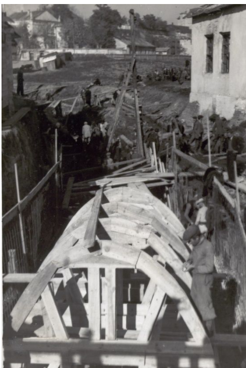
Rys. 78. Montaż krążyn wewnętrznych pod szalunek ustroju przesklepienia na zakolu Czechówki pomiędzy ul. Jateczną, a ul. Mostową. Widok w kierunku ul. Mostowej. W tle cerkiew, po prawej krawędź zabudowań pod adresem ul. Sienna 2. Autor nieznany, Kolekcja Jolanty i Wojciecha Jurkiewiczów, 1937
