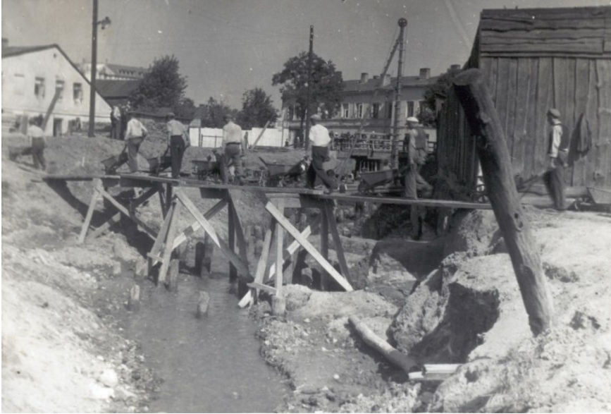
Rys. 79. Roboty ziemne i palowe przy budowie przesklepienia w obszarze jego końca przy adresie Plac Krawiecki 5 (dzisiaj nieistniejący). Widok w kierunku mostu na ul. Jatecznej. Po lewej zabudowania pod adresem Jateczna 49, w tle „biskupiak” i zabudowania pod adresem ul. Sienna 2. Autor nieznan, Kolekcja Jolanty i Wojciecha Jurkiewiczów, 1937
