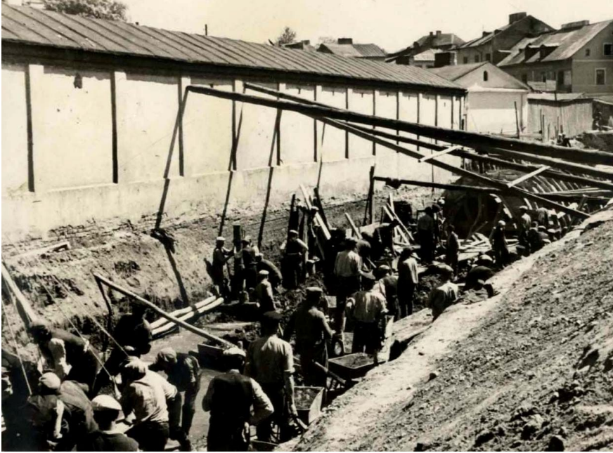
Rys. 91. Prace fundamentowe i zabezpieczenie wykopu podczas III etapu przesklepienia. Widoczne szalunki przesklepienia od ul. Nadstawnej w kierunku do ul. Furmańskiej. Po lewej jatkę na placu targowym. Autor nieznan, Archiwum Państwowe w Lublinie, wg [88]
