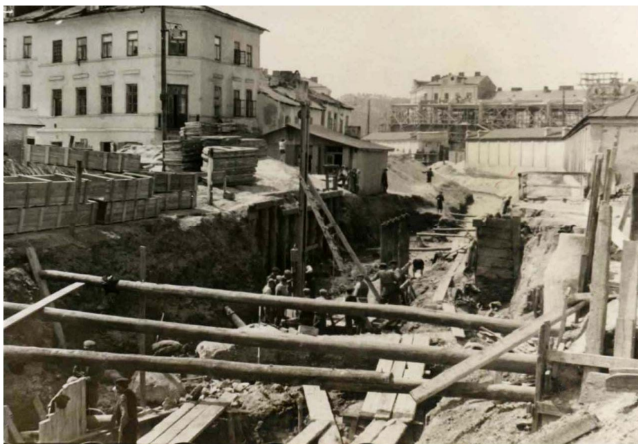
Rys. 32. Rozbiórka most na ulicy Nadstawnej w okresie budowy przesklenia Czechówki. Autor nieznany, Archiwum Państwowe w Lublinie, wg [55]
