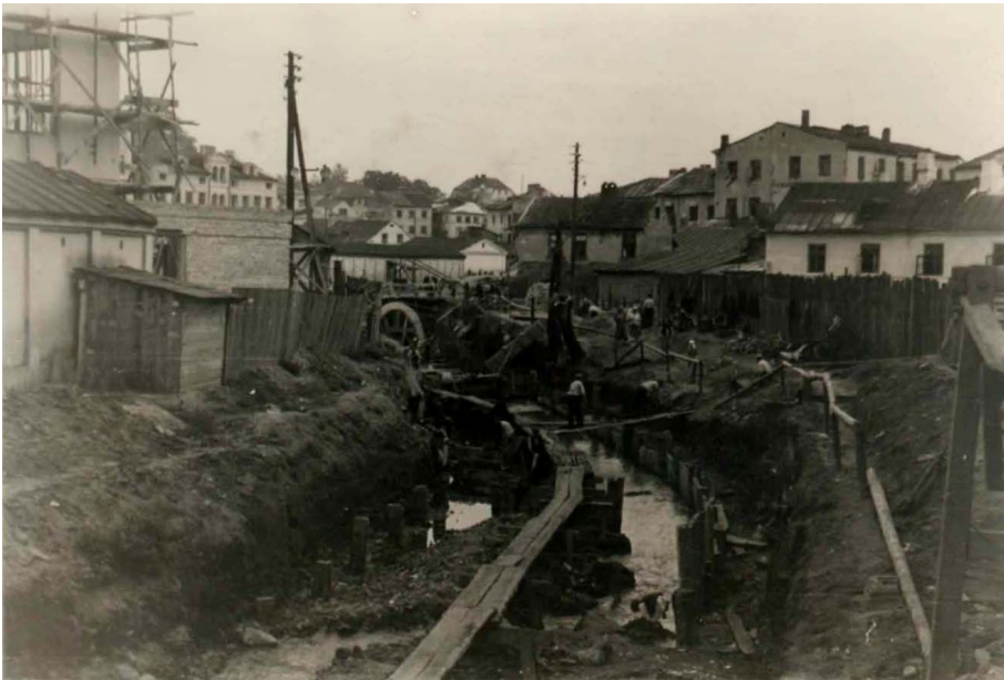
Rys. 88. Wbijanie pali kierunkowych ścianek szczelnych i prace ziemne w zakresie III etapu. W oddali widoczny gotowy segment w obszarze ul. Furmańskiej. Widok na Czwartek, po lewej jatki i hala targowa w trakcie budowy. Autor nieznanym, Archiwum Państwowe w Lublinie, wg [85]
