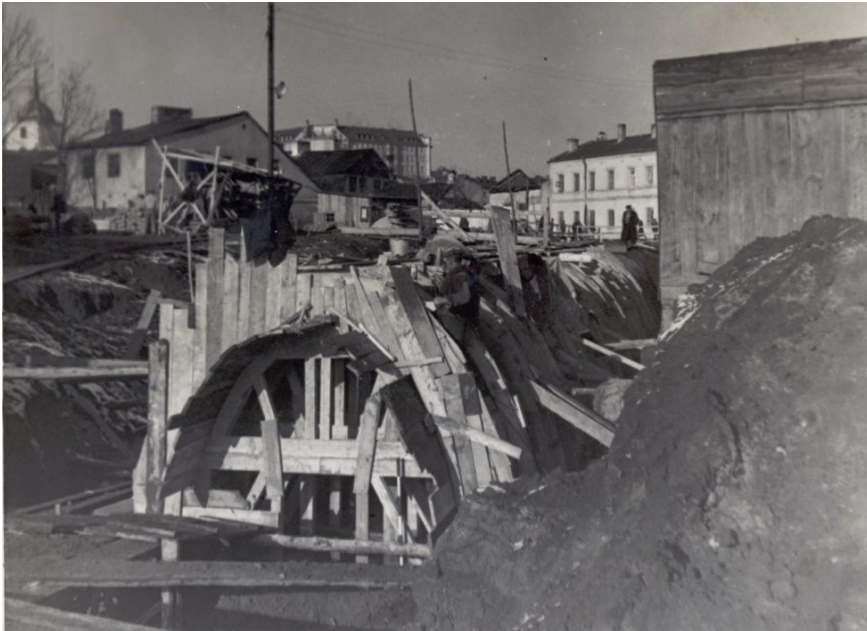
Rys. 80. Montaż krążyn zewnętrznych pod szalunek ustroju przesklepienia w obszarze końca przesklepienia przy adresie Plac Krawiecki 5. Autor nieznan, Kolekcja Jolanty i Wojciecha Jurkiewiczów, 1937
