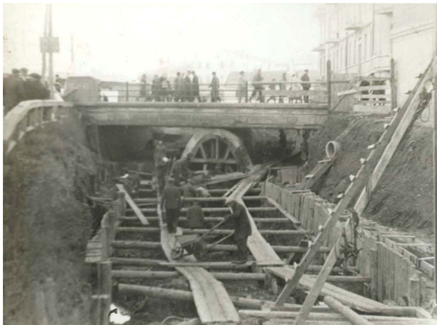
Rys. 70. Most żelazno-betonowy na ul. Lubartowskiej w czasie budowy IV etapu przesklepienia rzeki Czechówki. Widok w kierunku zamku. Autor nieznany, Archiwum Państwowe w Lublinie, wg [66]
