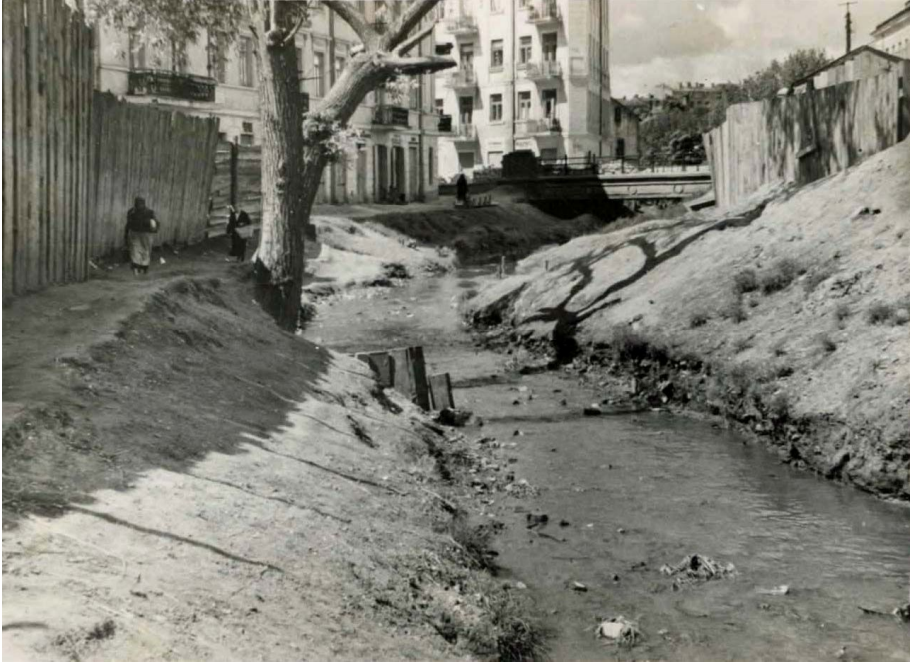
Rys. 68. Most żelazno-betonowy na ul. Lubartowskiej. Widok od strony Czechowa. Po lewej adres nieistniejącej Lubartowska 15. Autor nieznan, Archiwum Państwowe w Lublinie, wg [64]
