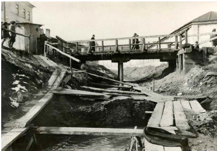
Rys. 31. Ostatnie chwile mostu na ulicy Nadstawnej w okresie budowy przesklenia Czechówki. Autor nieznany, Archiwum Państwowe w Lublinie, wg [54]
