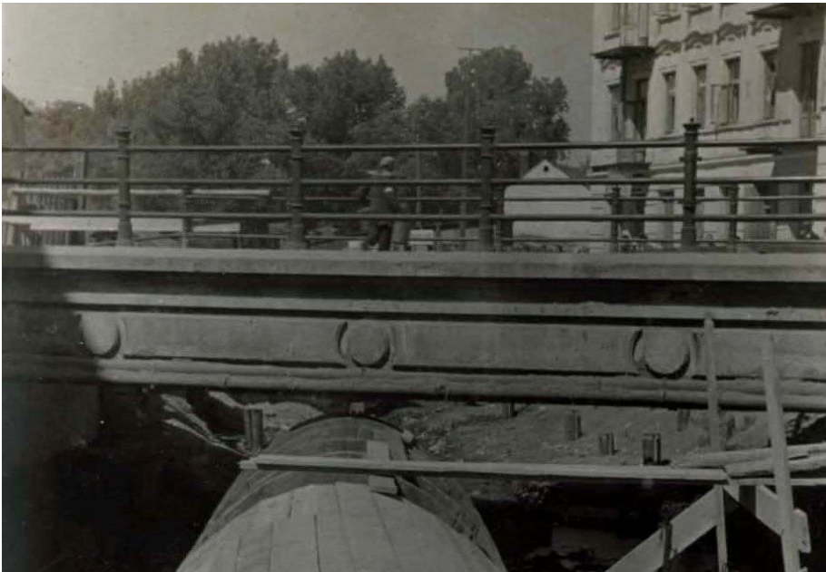
Rys. 69. Most żelazno-betonowy na ul. Lubartowskiej podczas budowy przeklepienia Czechówki. Widok w kierunku Czechowa. Autor nieznan, Archiwum Państwowe w Lublinie, wg [65]
