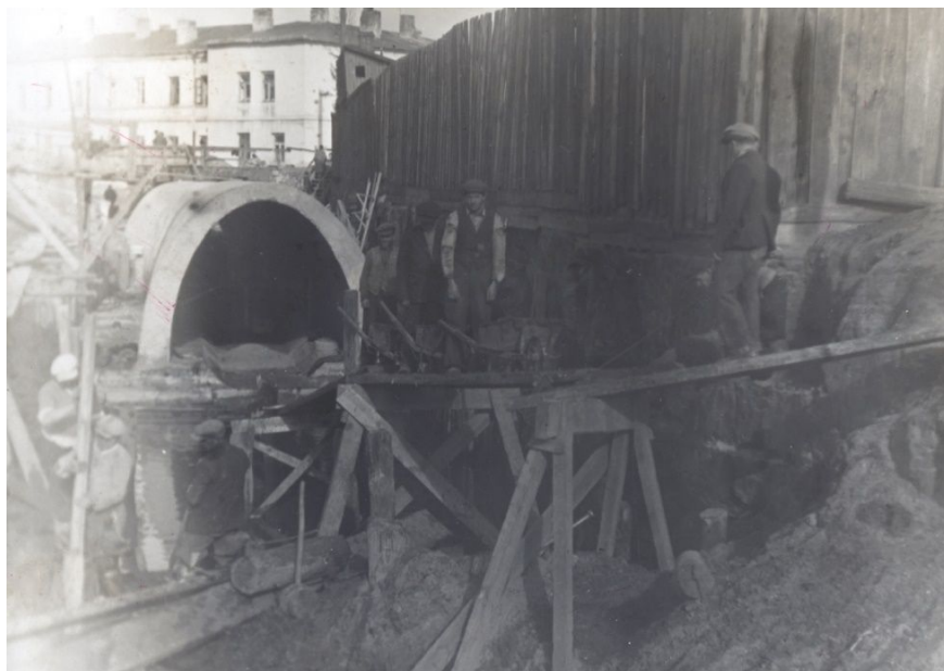
Rys. 82. Gotowy segment przesklepienia od ul. Jatecznej w kierunku Bronowic. W tle budynek przy ul. Siennej 2. Autor nieznany, Kolekcja Jolanty i Wojciecha Jurkiewiczów, 1937
