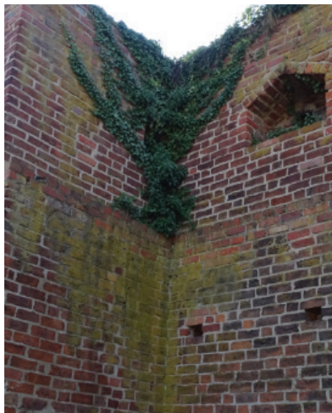
Fot. 23 Rozwój glonów i porostów w narożu muru bezpośrednio pod porastającym mur i koronę bluszczem
