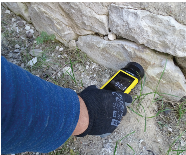
Fot. 17 Pomiar wilgotności metodą mikrofalową
