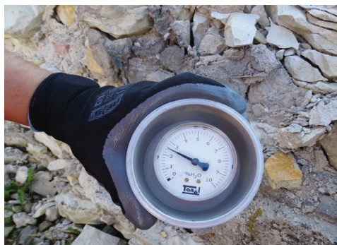
Fot. 19 Badanie wilgotności metodą karbidową odczyt ciśnienia acetyleny w zbiorniku
