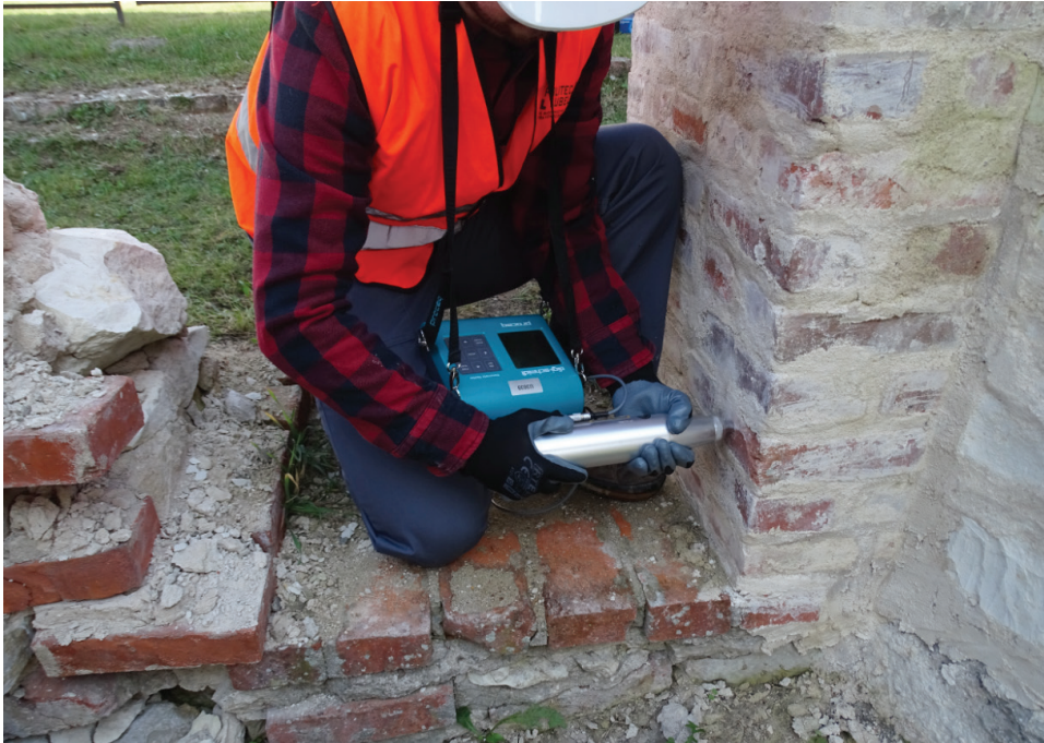
Fot. 8 Widok podczas padania sklerometrycznego
