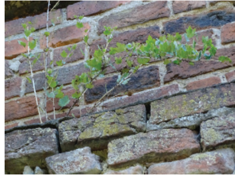
Fot. 37 Krzew z systemem korzennym przerastającym mur z cegły ceramicznej
