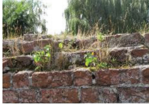
Fot. 31 Ekspansja roślin niskich i mchów na koronie muru z cegły ceramicznej. W pierwszym planie widoczne młode krzewy
