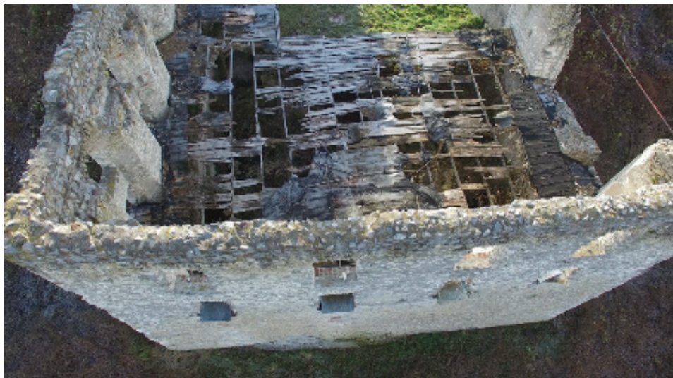
Fot. 3 Zdjęcie korony muru wykonane przy pomocy drona
