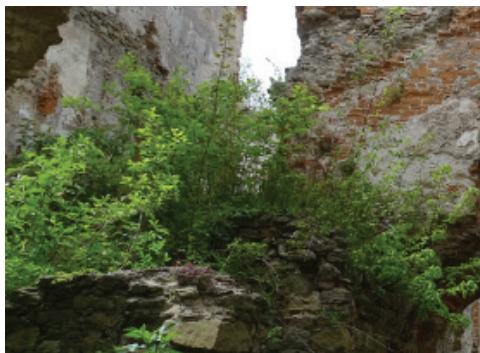
Fot. 34 Fragment sklepienia intensywnie porośnięty krzewami
