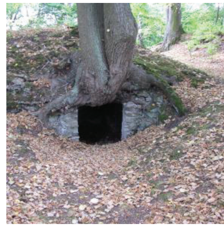
Fot. 39 Olbrzymie drzewo przeraastające systemem korzennym sklepienie z kamienia
