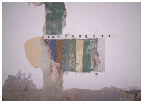
Fot. 21 Sonda schodkowa ukazująca układ warstw tynków i malatur na ścianie
