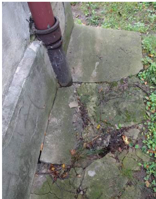
Fot. 4.74. Liczne uszkodzenia opaski
