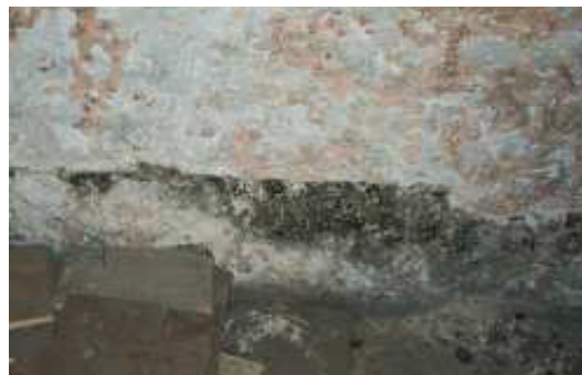
Fot. 4.36. Izolacja z papy wyciągnięta ponad podłogę [44]
