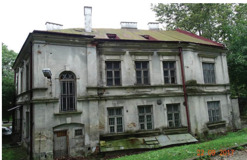
Fot. 3.4. Elewacja północna (należy podać kierunek elewacji)
