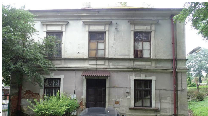
Fot. 3.3. Elewacja frontowa, wschodnia (należy podać kierunek elewacji)
