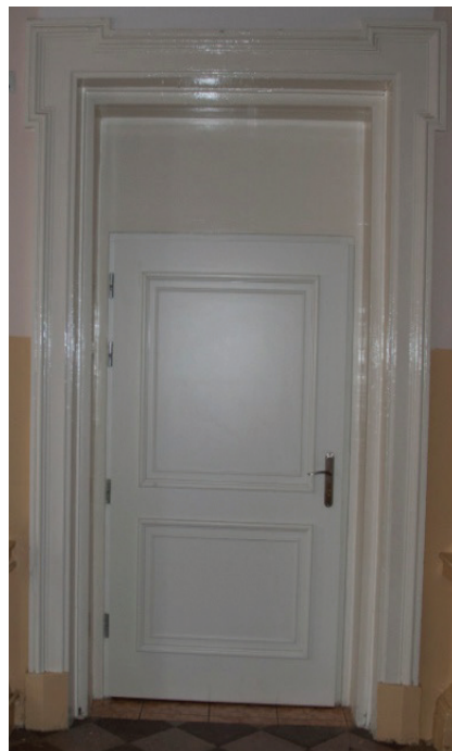
Fot. 3.18. Ozdobne obramowanie otworu drzwiowego
