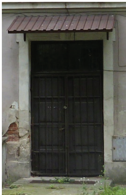
Fot. 3.12. Obramowanie drzwi głównych. Wykonano ozdobną opaskę dookoła otworu drzwiowego
