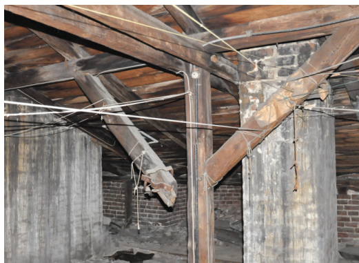
Fot. 4.2. Awaria połączenia miecza ze słupkiem [44]
