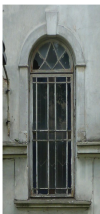
Fot. 3.9. Obramowanie okna klatki schodowej wykonane w formie łukowej ze zwornikiem na szczycie
