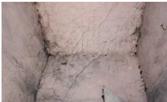
Fot. 4.35. Rysy konstrukcyjne nad otworem drzwiowym [44]
