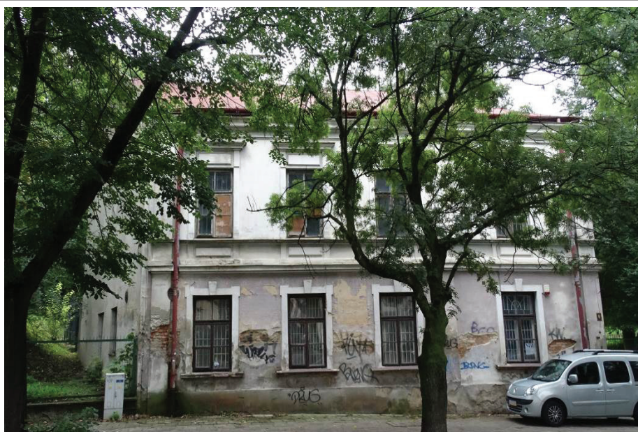
Fot. 4.59. Elewacja południowa, widok od ulicy Biernackiego
