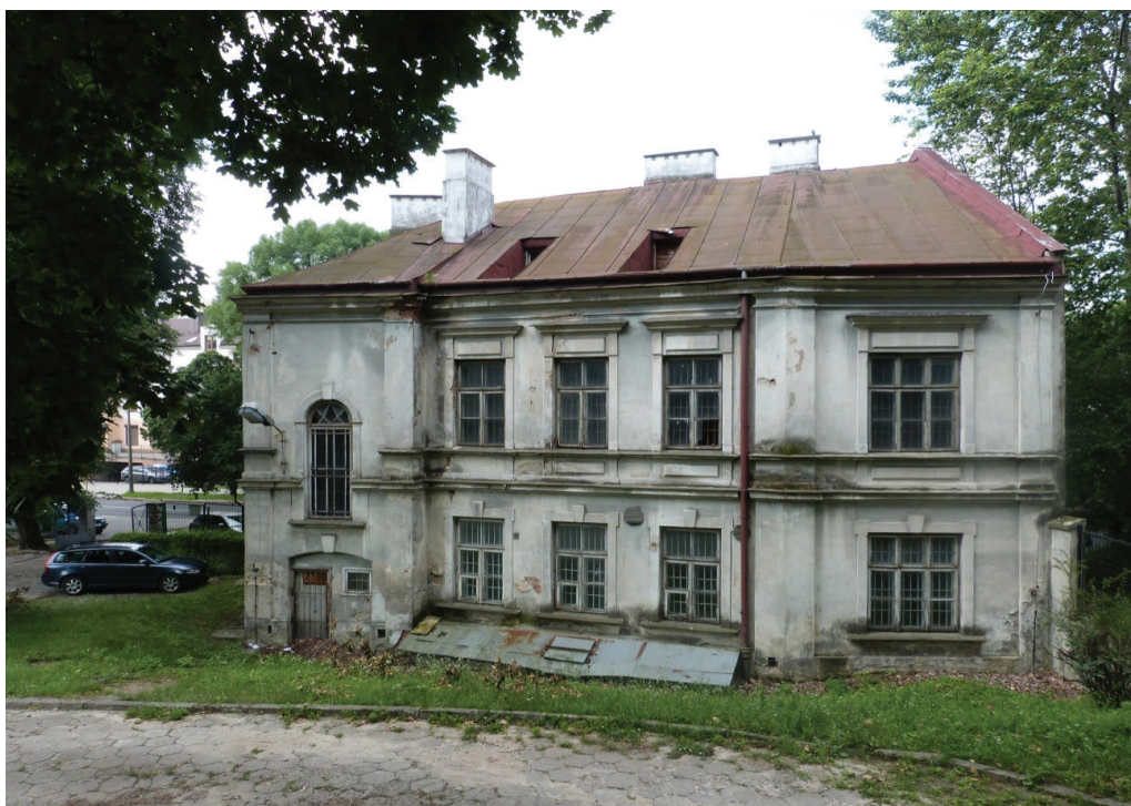
Fot. 4.45. Elewacja północna
