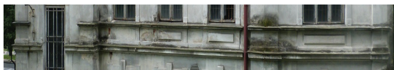
Fot. 3.8. Gzyms podokienny zespolony z gzymsem międzypiętrowym – kordonowym, przestrzeń między gzymsami wypełniona ozdobnymi płycinami
