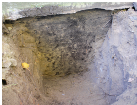
Fot. 4.44. Ściana fundamentowa – izolacja z papy
