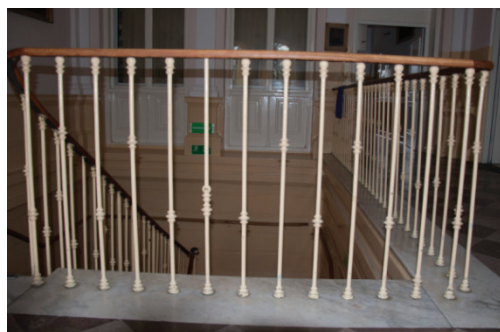
Fot. 3.20. Balustrada klatki schodowej
