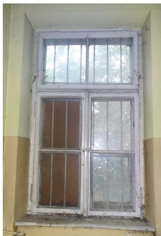
Fot. 4.32. Uzupełnienie sklejką braków w oszkleniu
