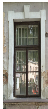
Fot. 3.11. Obramowanie okna na parterze. Na środku górnej części znajduje się detal przypominający zwornik łuku
