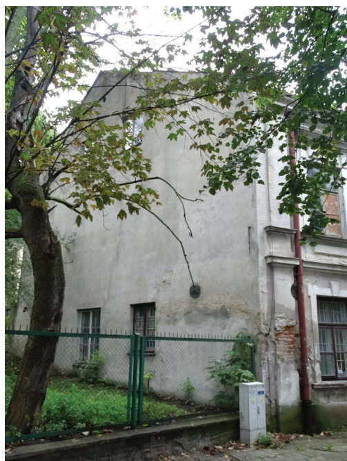
Fot. 3.5. Elewacja zachodnia (należy podać kierunek elewacji)
