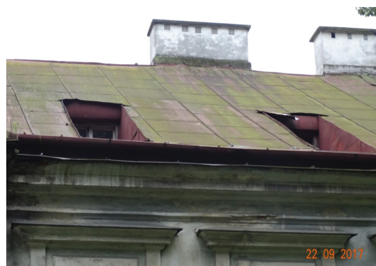
Fot. 4.14. Uszkodzenia obróbek blacharskich nad lukarnami, brak szczelności obróbek kominowych, brak kratki zabezpieczającej przewód wentylacyjny
