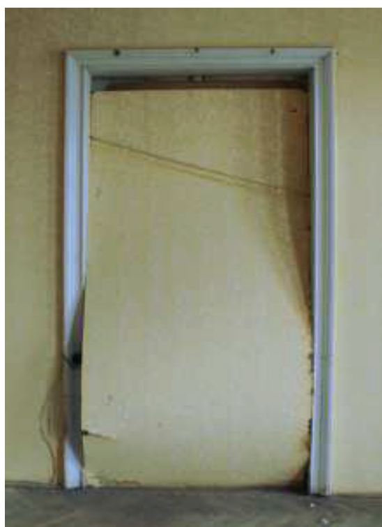
Fot. 4.31. Zasłonięcie otworu drzwiowego [44]
