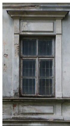
Fot. 3.10. Obramowanie okna na pierwszym piętrze, powyżej, jak i poniżej, okna znajduje się ozdobna płycina
