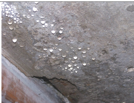
Fot. 4.39. Kondensacja powierzchniowa pary wodnej na stropie piwnic
