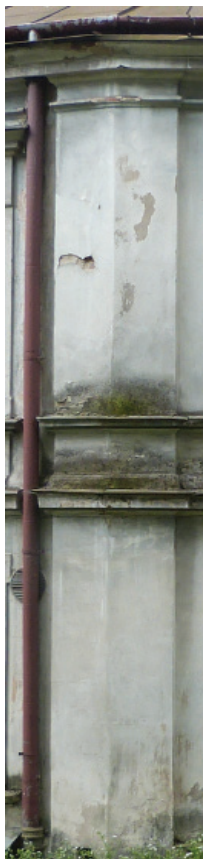
Fot. 3.14. Pilaster łączący dwie ściany, na górze przechodzi przez niego gzyms koronujący a w połowie wysokości gzyms podokienny oraz kordonowy
