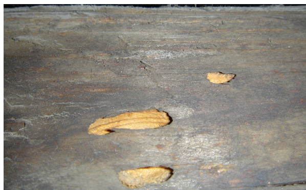
Fot. 4.11. Krokiew – otwory wylotowe spuszczała pospolitego
