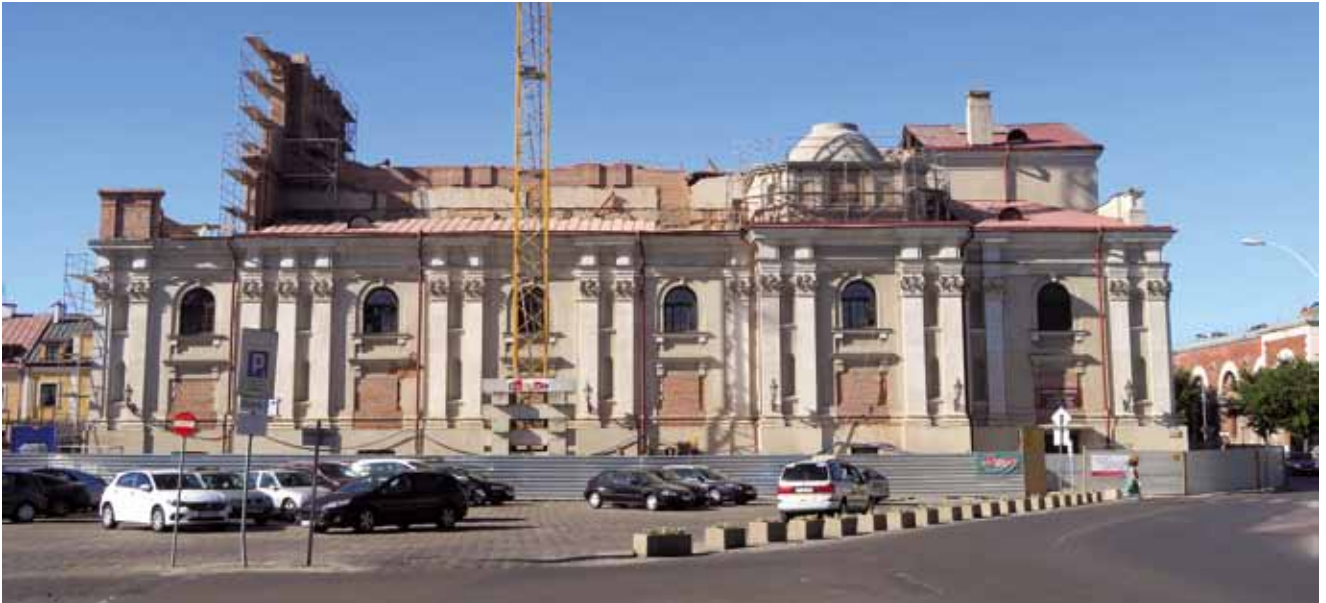
Kościół franciszkanów podczas prac rekonstrukcyjnych, stan z lata 2018
