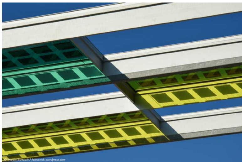
Fig. 5. The glass PV module with color PVB resin. shading element at Parc de Can Riga, Barcelona (arch. Claudi Aguiló Riu, Eva Pagès (arquitectos – AMB, 2012) – photographs by M. Muszyńska-Łanowy.
