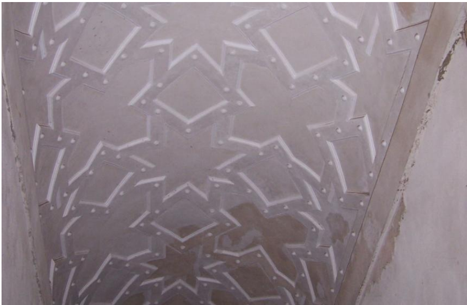
Fot. 4. Wiśnicz. Zamek. Sklepienie klatki schodowej (1615–1621 r.)
