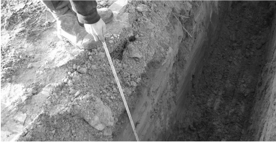
Fot. 7.3. Pomiary kontrolne podczas pogłębiania wykopu
