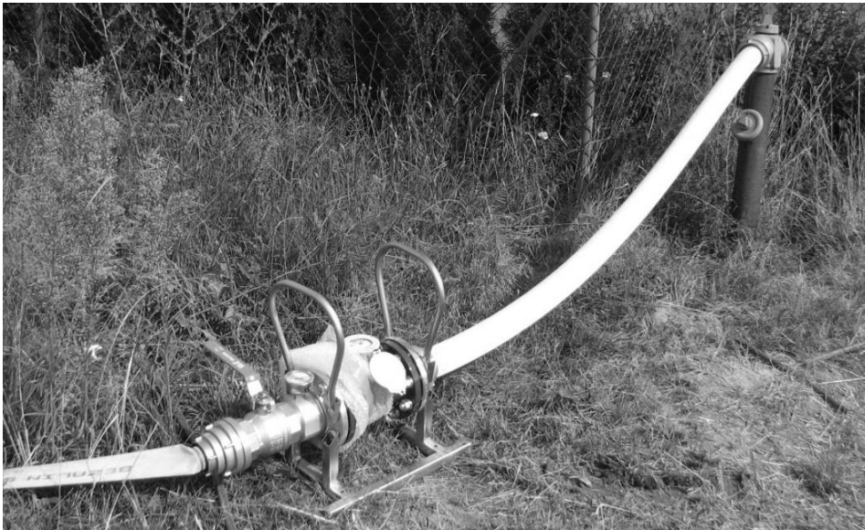
Fot. 7.9. Hydrant wykorzystany do zasilania stanowisk badawczych na obiekcie OT2 oraz zestaw do pomiaru ciśnienia i ilości zużytej wody
