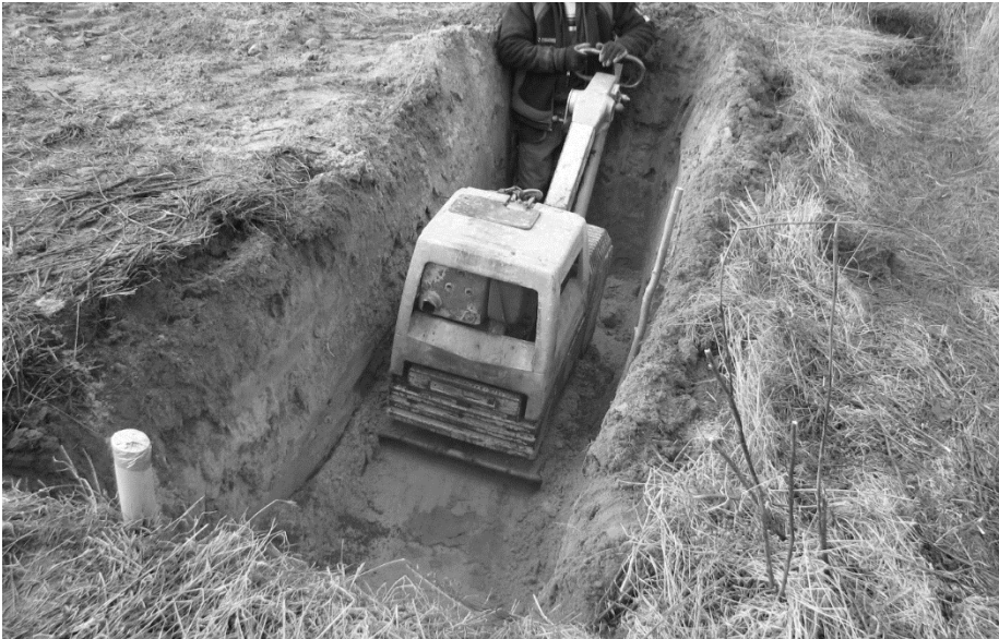
Fot. 7.2. Zagęszczanie warstw gruntu podczas zasypywania wykopu
