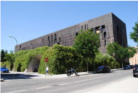
Ryc. 9. Trzcina elewacja Carabanchel Social Housing (2007, arch. Farshid Moussavi, Alejandro Zaera-Polo – Foreign Office Architects).
