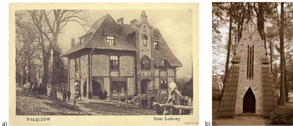
Ryc. 8. Witrażowy wątek wykonany z „siwaka” w formie płaskiej dzikówki w elewacji Domu Ludowego w Nałęczowie (a), mauzoleum Adama Żeromskiego w Nałęczowie (b).
