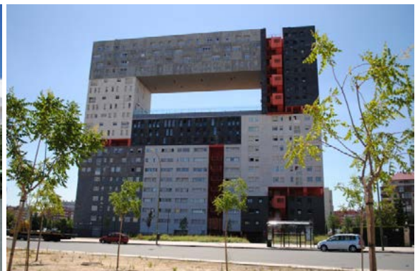
Ryc. 12. Edificio Mirador w Las Tablas – budynek o skomplikowanej (mostowej) konstrukcji przewieszania (2005, arch. MVRDV).
