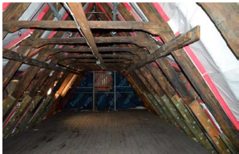
Fot. 50. Więźba dachowa budynku młyna. Fot. A. Fortuna-Marek
