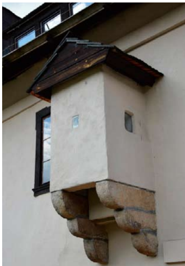
Fot. 27 Wykusz latrynowy w południowej elewacji młyna. Fot. A. Fortuna-Marek
