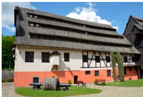
Fot. 26 Południowa elewacja młyna. Fot. A. Fortuna-Marek
