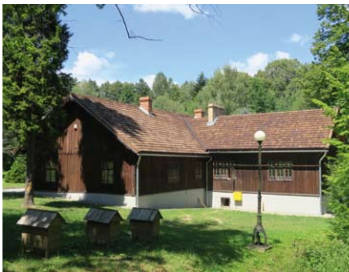
Fot. 45 Budynek administracyjny z 1864 r. tzw. Dom Ignacego Łukasiewicza, fot. A. Fortuna-Marek
