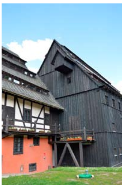
Fot. 31. Fragment młyna i suszarni od południowego zachodu. Fot. A. Fortuna-Marek
