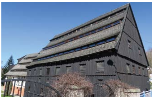
Fot. 11. Budynek suszarni. Widok od południowego wschodu. Fot. A. Fortuna-Marek
