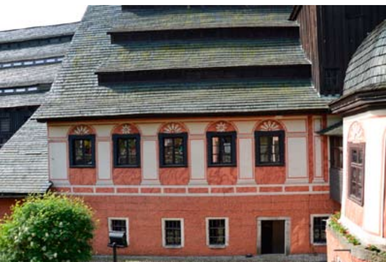
Fot. 22 Fragment północnej elewacji młyna. Fot. A. Fortuna-Marek
