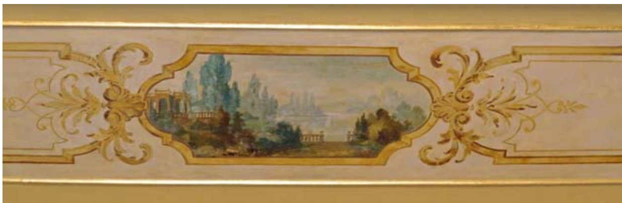
Fot. 80 Dekoracja malarska Reduty, w sali konferencyjno – balowej, fot. A. Siwek
