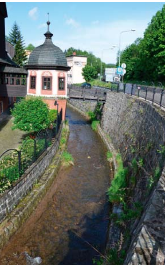
Fot. 14. Pawilon wejściowy nad Bystrzycą Dusznicką. Widok od wschodu. Fot. A. Fortuna-Marek
