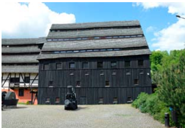
Fot. 30. Południowa elewacja suszarni. Fot. A. Fortuna-Marek
