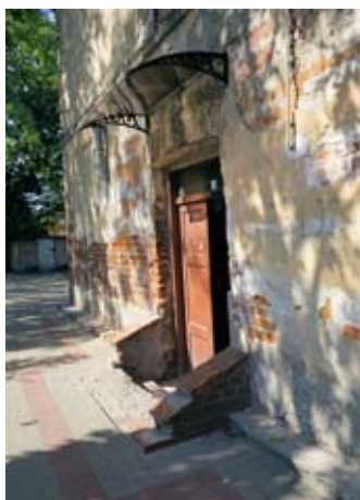
Fot. 57 Fragment elewacji budynku mieszkalnego fot. A. Siwek
