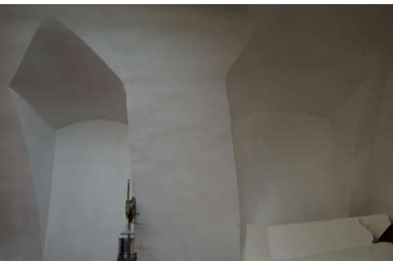
Fot. 49. Sklepienie kolebkowe z lunetami w przyziemiu młyna. Fot. A. Fortuna-Marek
