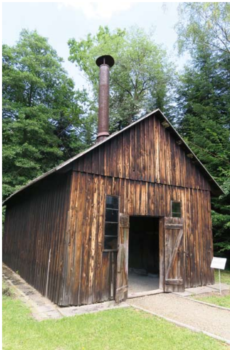
Fot. 44 Budynek kotłowni z 1867 r., fot. A. Fortuna-Marek
