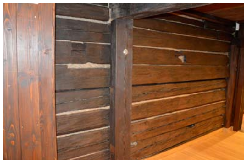
Fot. 52. Fragment konstrukcji zrębowej najstarszej części suszarni. Fot. A. Fortuna-Marek
