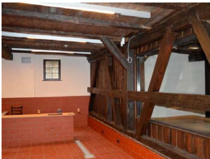
Fot. 42. Wnętrze suszarni po pracach remontowych. Fot. A. Fortuna-Marek
