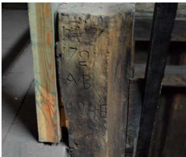
Fot. 51. Stup konstrukcyjny schodów w budynku młyna. Fot. A. Fortuna-Marek
