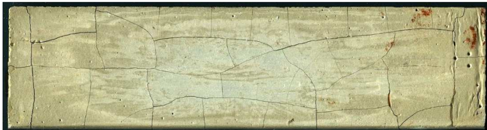
Rys. 3.2. Spękania termiczne (klastrowe) zaczynu cementowego z cementu portlandzkiego o w/c = 0,5 [M. Szelağ]
