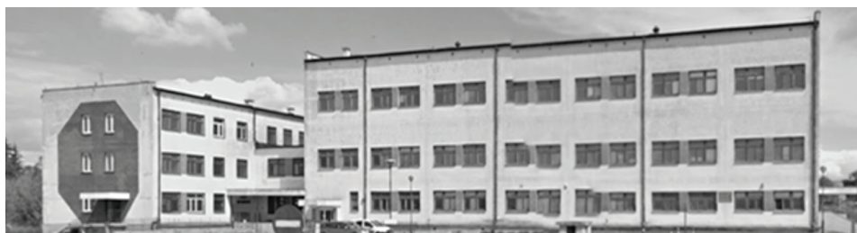
Rys. 11. Budynek przewidziany do rewitalizacji
