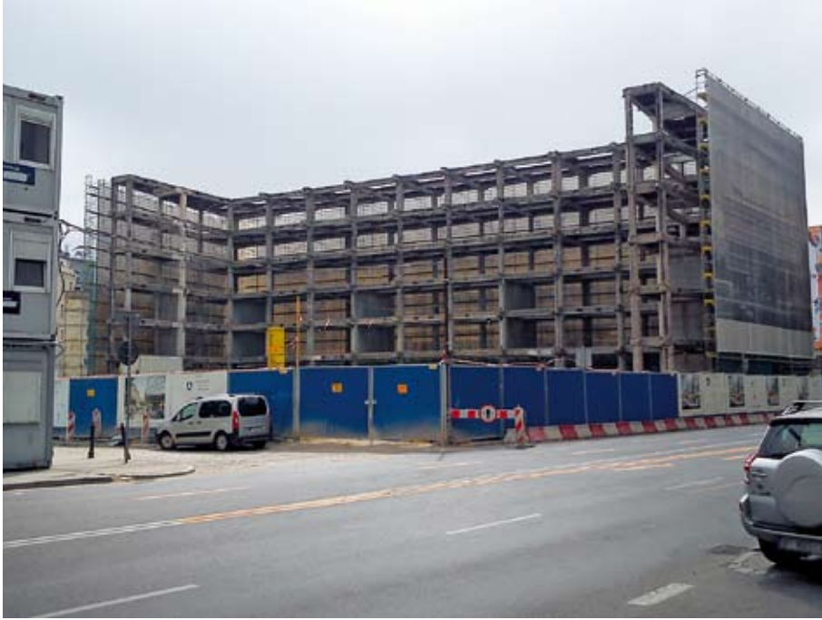
Fot. 2. CDT „Smyk” w trakcie „przebudowy”, widok od ul. Kruczej (fot. J. Dąbrowski)
