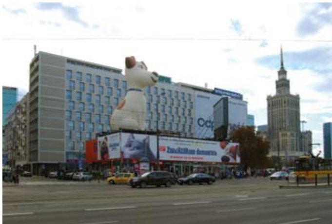
Fot. 8. Warszawa, ul. Marszałkowska, pawilon Cepelii, proj. Zygmunt Stepiński, konstr. Aleksander Haweman, realizacja do marca 1966. Doskonale zachowany budynek o wartości ponadregionalnej nie wpisany do rejestru zabytków podlegający coraz większej degradacji. Fot. J. Lewicki 2016.
