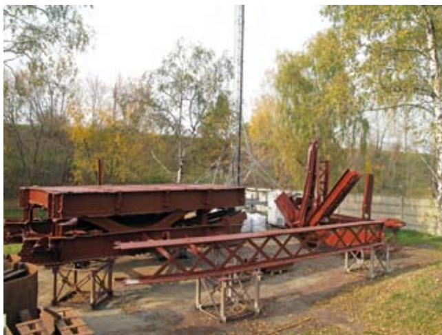
Ryc. 3 Wydobyte fragmenty warszawskich mostów po zabezpieczeniu antykorozyjnym (fot. B. Rymcza)
