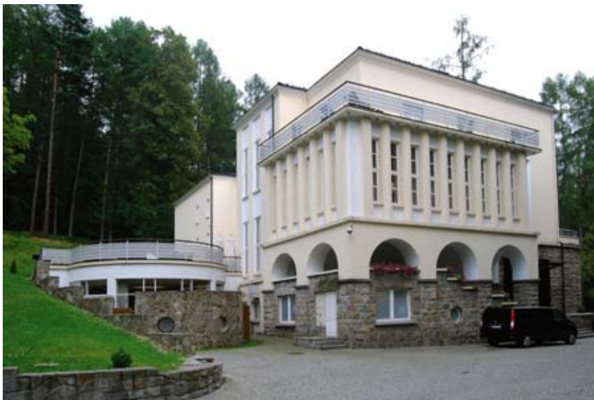
Fot. 6. Szczawnica, budynek sanatoryjny, lata 30 XX wieku, proj. Z. Rzepecki (?). Budynek o wartości ponadregionalnej nie wpisany do rejestru zabytków. Fot. J. Lewicki 2016.
