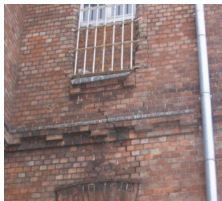
Rys. 5.1. Stan techniczny ceglanych elewacji. Uszkodzenia części murów wynikające z dużego zawilgocenia, korozji mrozowej i obecności soli rozpuszczalnych [24]
