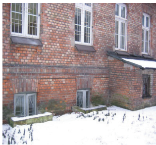
Rys. 5.1. Stan techniczny ceglanych elewacji. Uszkodzenia części murów wynikające z dużego zawilgocenia, korozji mrozowej i obecności soli rozpuszczalnych [24]
