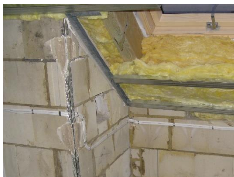
Rysunek 3.5.4. Fragment ścianki kominowej przed położeniem warstwy tynkowej
