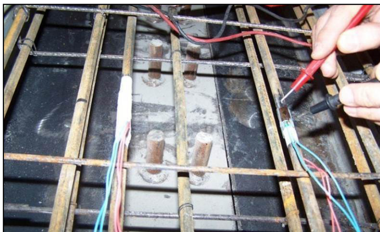
Fot. 3. Montaż tensometrów na zbrojeniu [autor K. Śledziwski]
