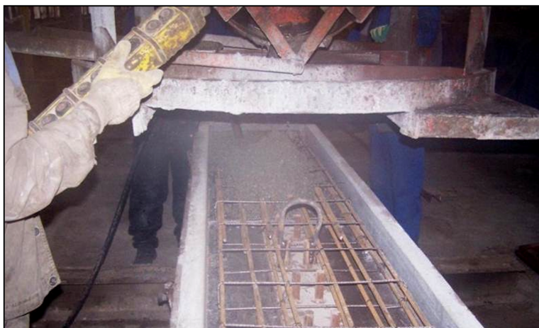
Fot. 4. Betonowanie płyty górnej [autor K. Śledziewski]
