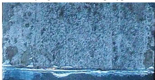
Zdj.4.1. Zniszczenie na granicy stal-klej
