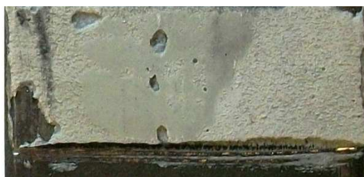
Zdj.4.3. Zniszczenie na granicy kompozyt-klej
