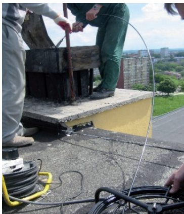
Ryc. 7 Badanie drożności wentylacji 11. kondygnacyjnego budynku prefabrykowanego Fig. 7. Ventilation ducts inspection in a 11-storey precast concrete plate building
