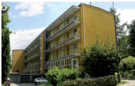
Ryc. 9. Widok elewacji a) północnej, b) południowej – stan czerwiec 2011 r.
