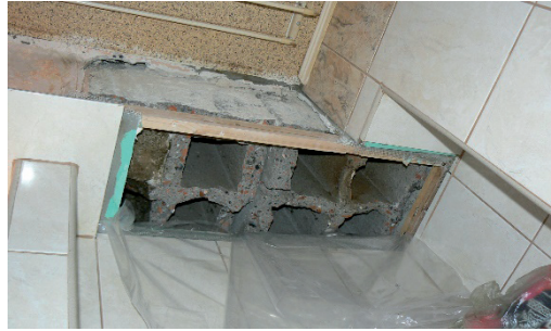
Ryc.6 Wentylacyjne kanały zbiorcze budynku prefabrykowany – samowolnie wyburzone Fig. 6. Common ventilation ducts - a precast ventilation block removed by the thoughtless flat owner
