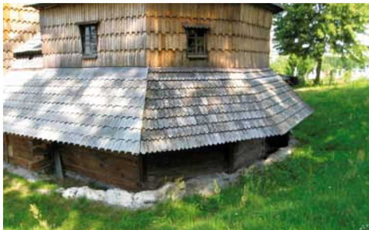
Fot. 5 Nieodpowiedni materiał pokrycia – gont wykonany z tworzywa sztucznego), fot. A. Fortuna-Marek
