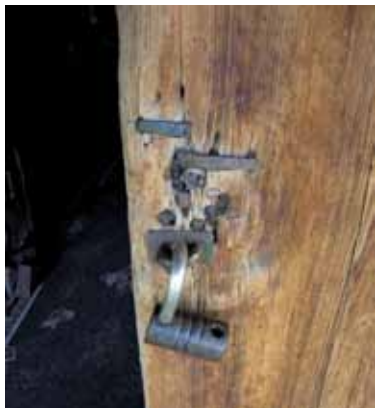
Fot. 7 Stan elementów zabezpieczających stwarzający bezpośrednie zagrożenie włamaniem, fot. A. Fortuna-Marek
