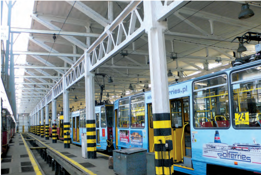
Fot. 6. Warszawa, Zakład Eksploatacji Tramwajów R-2 Praga, ul. Kawęczyńska 16, remiza, czyli zajezdnia tramwajowa, rejestr zabytków A-732 z 2.02.2007. Hala postojowa wzniesiona w latach 1923–1928; projektanci: arch. Juliusz Dzierżanowski (1873–1944) i arch. Paweł Wędrzicki (1883–1929). Szkieletowa konstrukcja żelbetowa wysadzona w powietrze przez hitlerowców we wrześniu 1944 r. została odbudowana w latach 1948–1953. Zachowano stylistykę art-déco słupa z głowicą, na której oparto filigranową żelbetową kratownicę, nawiązującą układem prętów do wiązara drewnianego lub dźwigara stalowego. Jest to przykład pietyzmu dla wartości historycznej obiektu infrastruktury miejskiej. Fot. W. Affelt, 2009
