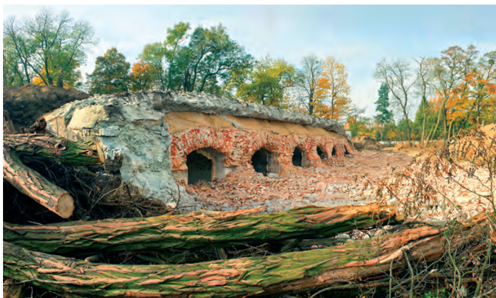
Il. 4. Schronie Piechoty 13 w trakcie wyburzania, 2014 (Ł. P.)
