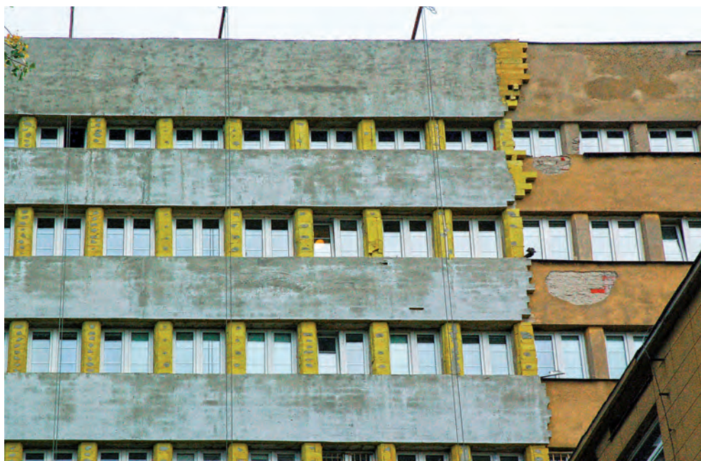
Fot. 4. Modernizacja elewacji przez wymianę stolarki i docieplenie metodą suchą powodujące likwidację dwuwarstwowego chropowatego tynku o regularnych podziałach zbliżonych do kwadratu – Warszawa, Al. Niepodległości 218, 1937–39 roku. Foto J. Lewicki, 2008.
