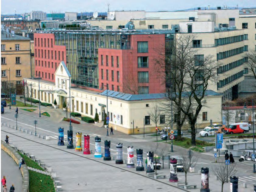
Fot. 14. Kraków, Hotel Sheraton, ul. Powiśle 7: rozwiązanie elewacji budynku zaskakuje postmodernistycznym kontrastem płaszczyzn; nie jest to jedynie kreacja architektoniczna, ale i także koncepcja konserwatorska ukazania przeszłości tego miejsca. Otóż kształt jasnej ściany przyziemia jest odtworzeniem zarysu bryły wzniesionego tu na przełomie XVII i XVIII wieków budynku Browaru Królewskiego, później przebudowywanego i używanego na różne cele do 2002 r. Nie zachowano nic z pierwotnej substancji zabytkowej tego ceglano-kamiennego muru, pokrytego wieloma warstwami tynku. Przyjęte rozwiązanie podnosi atrakcyjność turystyczną i biznesową tej lokalizacji, oferując wyjątkowy widok na Wzgórze Wawelskie, przy jednoczesnym upamiętnieniu nieistniejącego obiektu. „Kraków – historyczny zespół miasta” jest Pomnikiem Historii od 1994 r.; Browar Królewski znajdował się w granicach terenu objętego ochroną również jako miejsce Światowego Dziedzictwa UNESCO (1978 r.). Fot. W. Affelt, 2015
