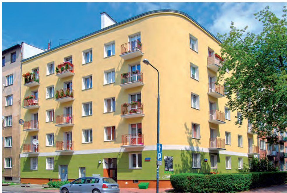
Fot. 3. Elewacja po modernizacji (docieplenie i wykonanie nowych tynków), której skutkiem jest pogrubienie ścian i ahistoryczna bryła z nową kolorystyką, Warszawa, ul. Kaliska 16, 1938–39. Foto J. Lewicki, 2015.
