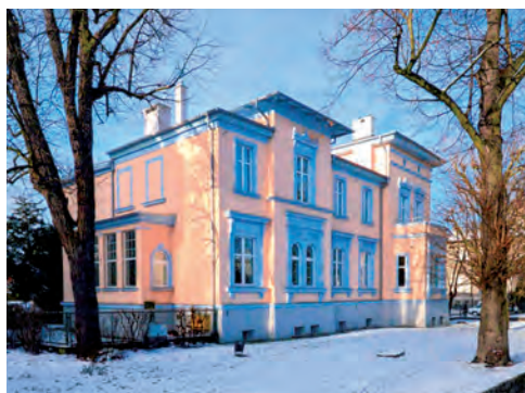
2015 SIEDZIBA PÓŁNOCNEJ IZBY GOSPODARCZEJ
