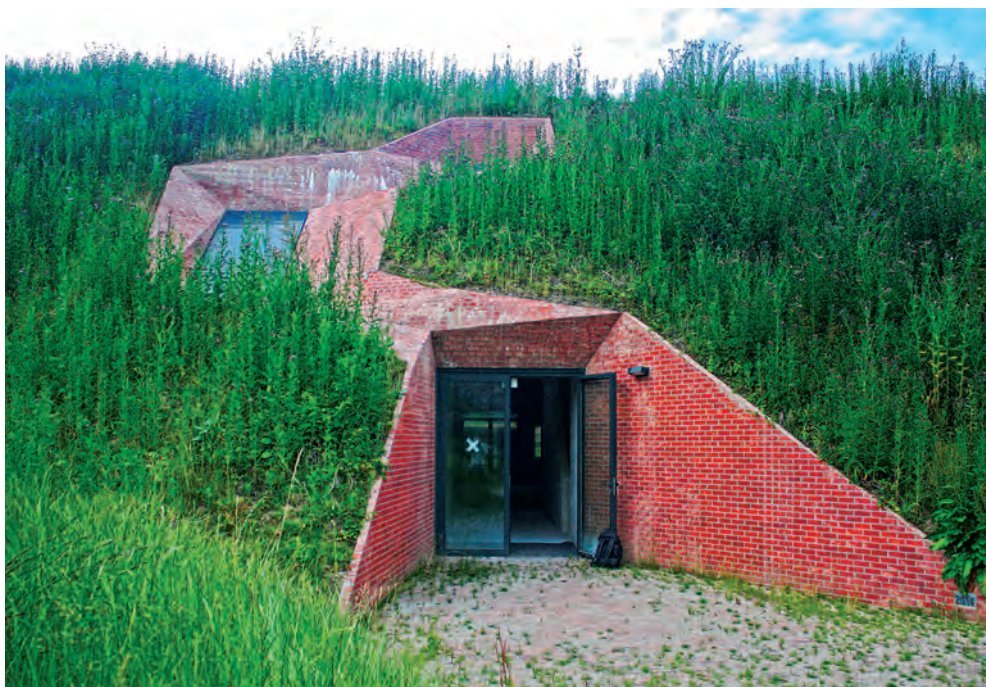
Il. 2. Ukończona rozbudowa schronu Fortu bij het Hemeltje z motywem ceglany nawiązującym do historycznej fasady, 2015 rok (Ł.P.)
