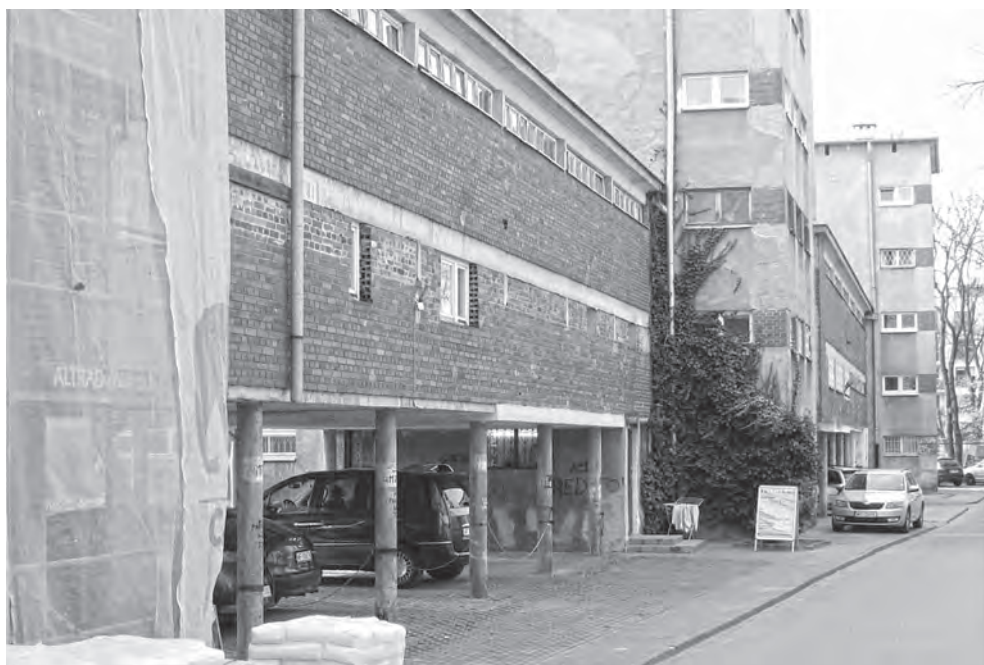
Fot. 5. Warszawa. Osiedle TOR na Grochowie. Budynki w trakcie renowacji elewacji. Widoczne zamurowania i nowe przebiecia w elewacji łącznika.
