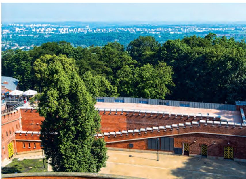
Fot. 5. Kurtyna I-V po konserwacji – widoczna pochylnia i północna ściana z krenelażami oraz taras z zadaszeniem antresoli w miejscu wału strzeleckiego, stan obecny, fot. L. Cierpiałowski, Komitet Kopca Kościuszki
