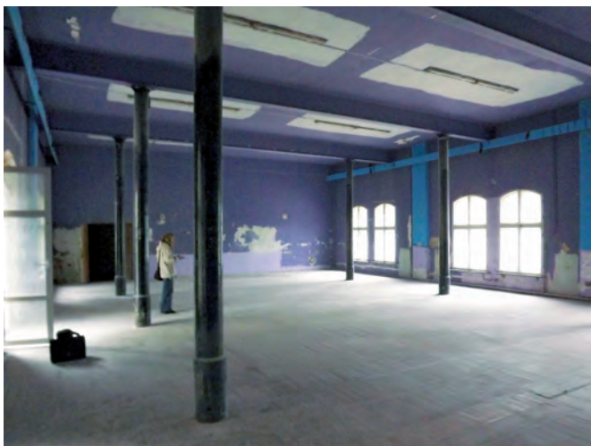
Fot. 3. Dawna poczekalnia dworcowa w Tczewie, obecnie adaptowana do funkcji biurowo-administracyjnej (MOPS); A. Widok ogólny; B. Widok wnętrza hali poczekalni z zachowanymi żeliwnymi kolumnami. Fot. M. Korpała, 2012.
