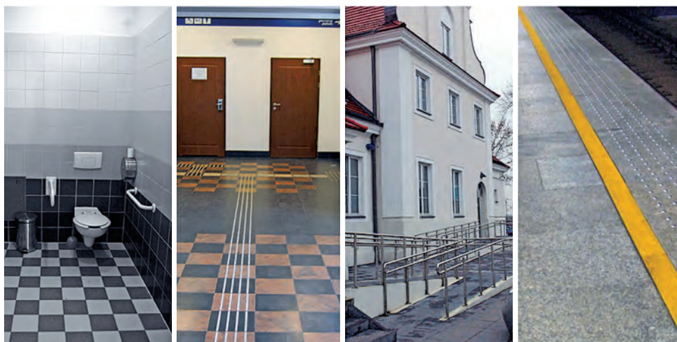
Il. 2. Przykłady dostosowania przestrzeni dworca kolejowego do potrzeb osób niepełnosprawnych: Od lewej: toalety dla niepełnosprawnych; ścieżki dla niewidomych; podjazd dla osób poruszających się na wózkach; oznaczenie krawędzi peronu - kontrast wizualny i linie dotykowe.
