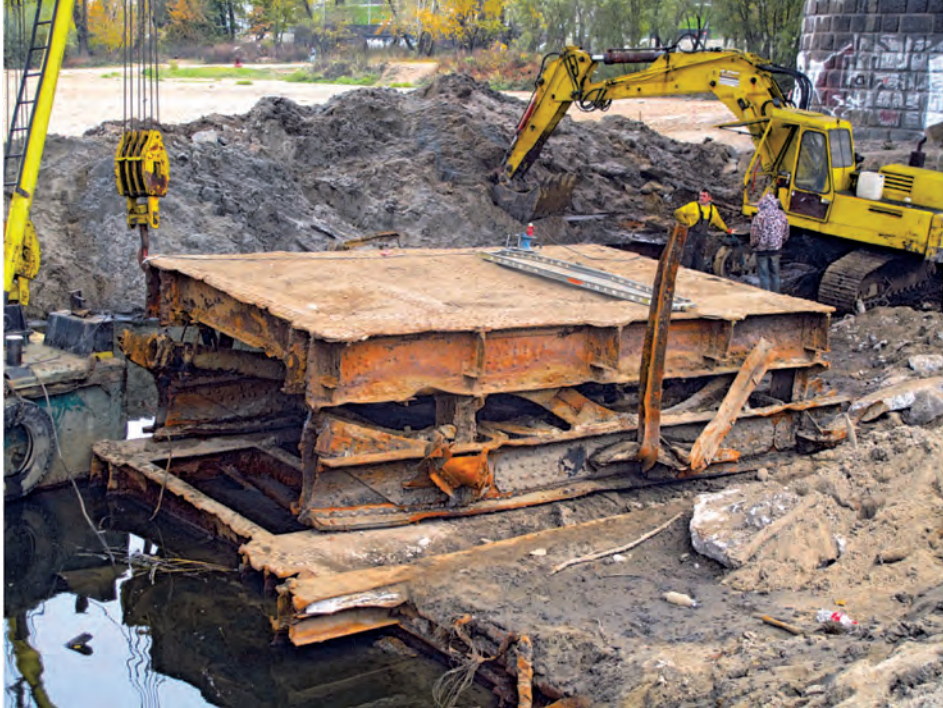
Rys. 4. Ratownictwo Wodne RAKO podczas prac przy wydobywaniu fragmentów Mostu im. Ks. J. Poniatowskiego (wrzesień 2012, fot. B. Rymsza)
