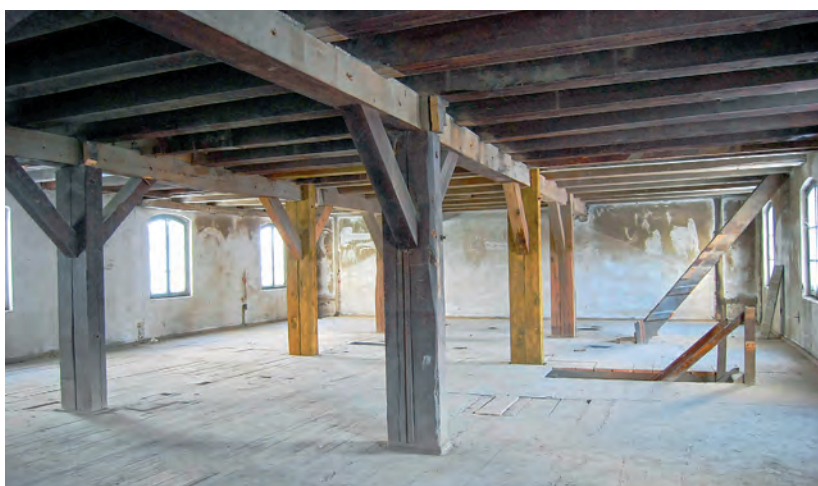
Fot. 2. Młyn zbożowy w Nowym Mieście Lubawskim, obecnie w trakcie adaptacji do funkcji usługowych (niepubliczna przychodnia zdrowia): A. Widok ogólny; B. Widok wnętrza z zachowaną konstrukcją drewnianą. Fot. M. Korpała, 2011.
