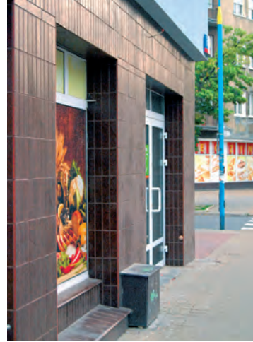
Fot. 1. Elewacja kamienicy o wysokich wartościach architektonicznych po modernizacji (docieplenie metodą lekką suchą, nowe tynki, kolorystyka i obróbki blacharskie oraz wymiana klinkieru akcentującego parter), które spowodowało zmianę plastyki przez „podcięcie” pogrubionych elewacji. Warszawa, ul. Filtrowa 64, proj. Lucjan Korngold, 1935–36. A. Widok ogólny; B. Fragment parteru z wymienionym klinkierem i wysunięciem górnej części pogrubionej elewacji. Foto J. Lewicki, 2015.
