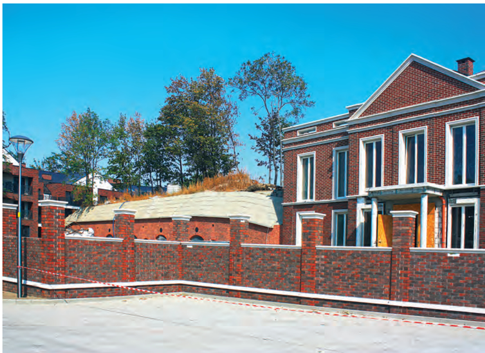
Il. 6. Schron Piechoty 1 widziany zza nowego ogrodzenia, 2015 (Ł. P.)
