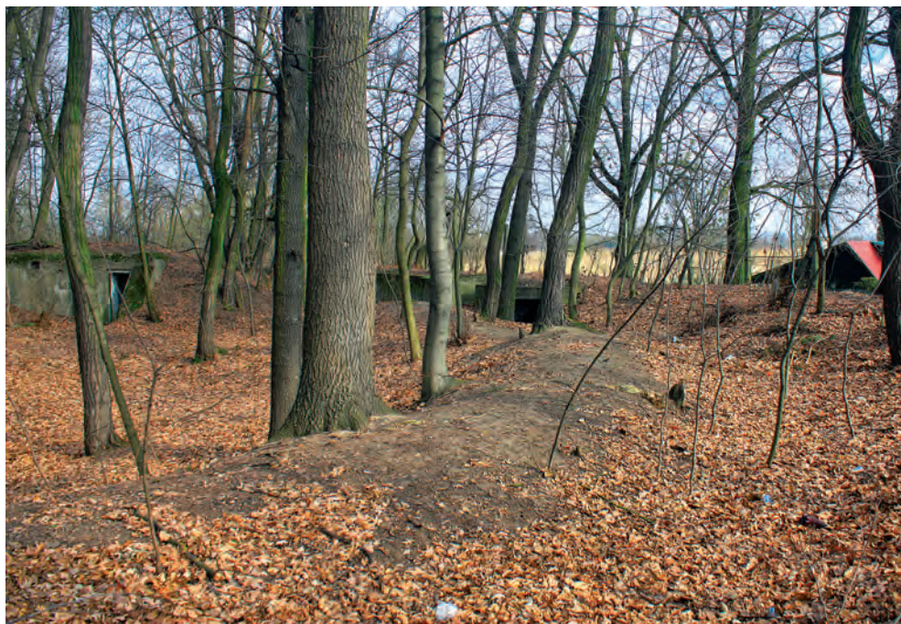
Il. 1. Wewnętrzny wał ziemnym Fortu Piechoty 4, 2014 (Ł. P.)
