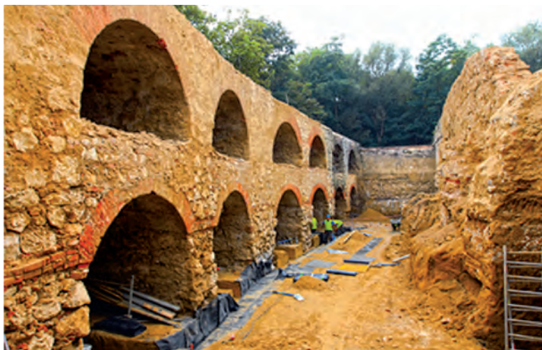
Fot. 2. Wnętrze kurtyny po usunięciu zasypu, 2011 r., fot. L. Cierpiałowski, Komitet Kopca Kościuszki
