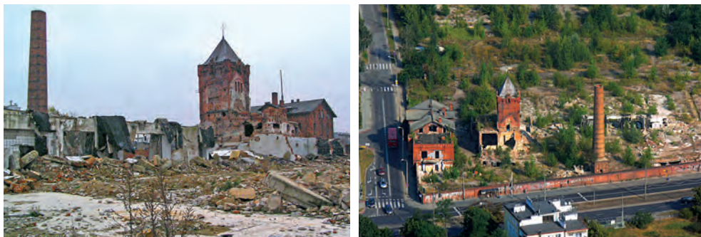
Ryc. 1. Toruń, dawna Rzeźnia Miejska, stan w roku 2004 /po lewej/ i 2009 /po prawej/. Obecnie na tym terenie pozostał jedynie komin. Fot. L. Narębski. (patrz przypis 5)
