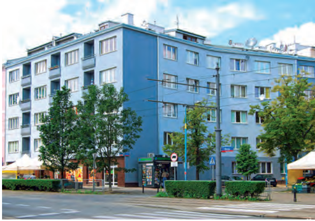
Fot. 1. Elewacja kamienicy o wysokich wartościach architektonicznych po modernizacji (docieplenie metodą lekką suchą, nowe tynki, kolorystyka i obróbki blacharskie oraz wymiana klinkieru akcentującego parter), które spowodowało zmianę plastyki przez „podcięcie” pogrubionych elewacji. Warszawa, ul. Filtrowa 64, proj. Lucjan Korngold, 1935–36. A. Widok ogólny; B. Fragment parteru z wymienionym klinkierem i wysunięciem górnej części pogrubionej elewacji. Foto J. Lewicki, 2015.
