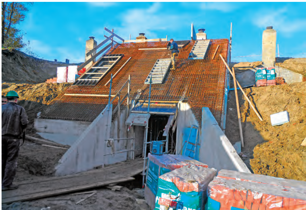
Il. 1. Rozbudowa schronu Fortu bij het Hemeltje w trakcie prac w nasypie czołowym, 2013 roku (Ł.P.)
