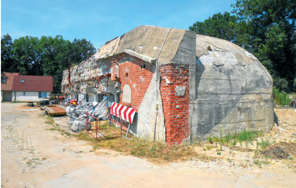
Il. 2. Schron koszarowy Fortu Piechoty 5 bez płaszcza ziemnego, 2014 (Ł. P.)
