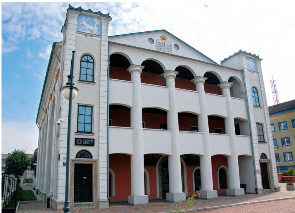
Ryc. 1. Elewacja frontowa z charakterystycznym krużgankiem (fot. Ryszard Nejman)
