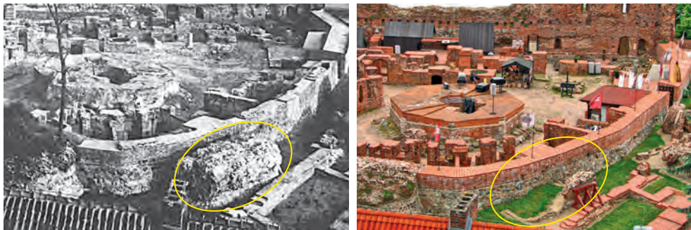
Ryc. 3. Toruń, zamek krzyżacki, ubytki trwałej ruiny. Stan w roku 1966, owalem zaznaczono bryłę obalonego muru obwodowego /po lewej/. To samo miejsce w roku 2015, widoczny niewielki zachowany fragment tej bryły, który wskutek ubytków utracił stabilność i musiał zostać podparty /po prawej/.
