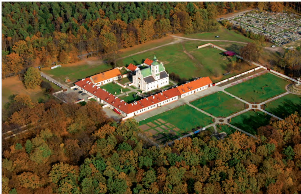
Il. 1. Rytwiany. Pustelnia Złotego Lasu, współczesny widok zespołu w trakcie prac konserwatorskich. Fot. Sz. Zabielski, zb. Archiwum w Rytwianach
