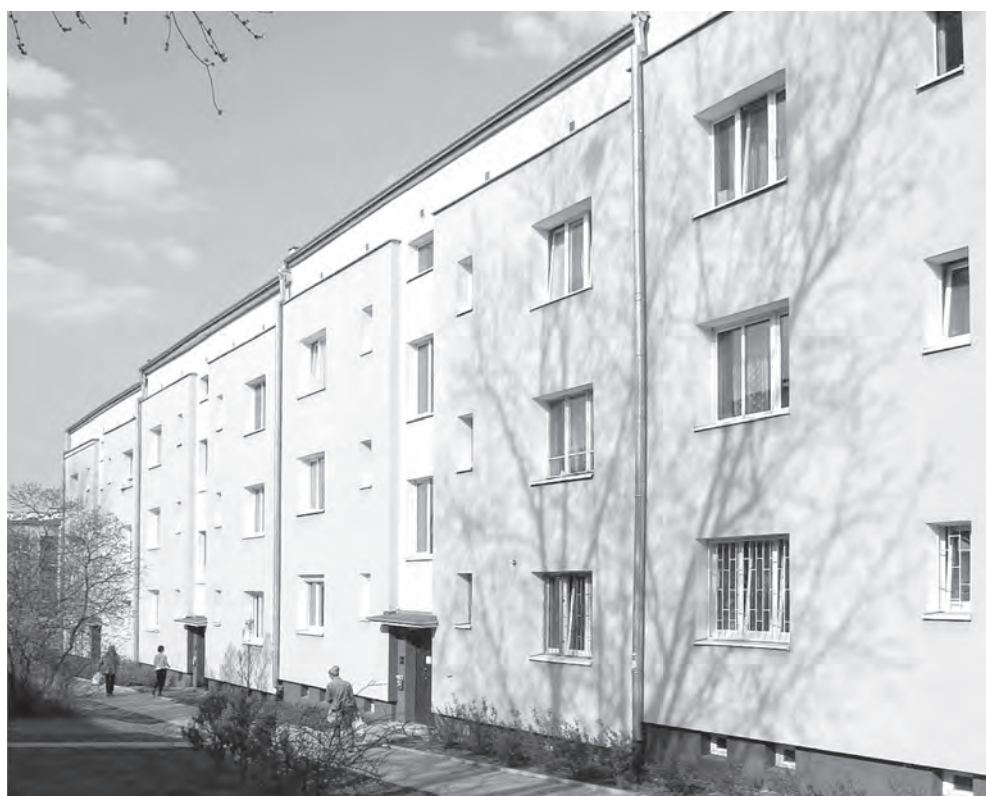
Fot. 3. Warszawa. Osiedle TOR na Kole. Zespół po południowej stronie ul. Obozowej. Budynek po przeprowadzonej termomodernizacji.
