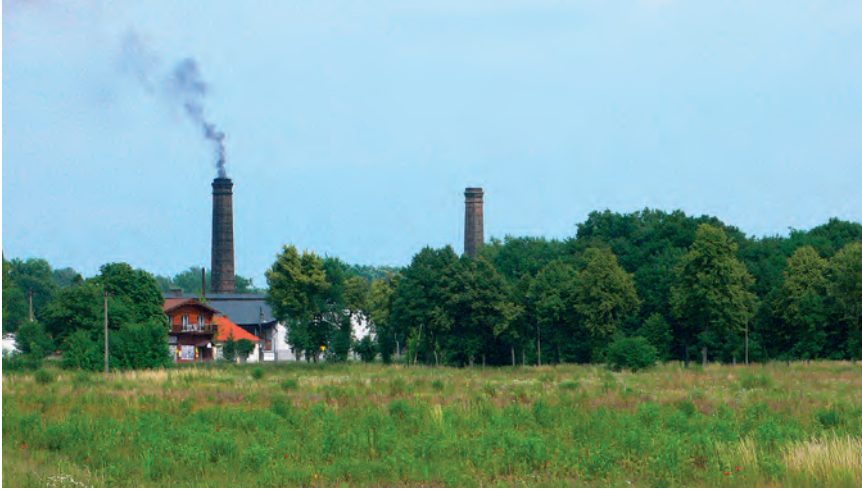
Fot. 8. Ciechocinek, PUC SA, Zabytkowa Warzelnia Soli, ul. Solna 6, rejestr zabytków A/1399 z 28.10.1958 i z 17.02.1981: radosny widok poświadczający, że warzelnia pracuje, bo widać dym z kominą; ten drugi komin i związany z nim zespół podgrzewaczy i panwi ogniowych zostały już na trwałe wyłączone z produkcji. Tutejszy wielkoprzemysłowy zakład, zaprojektowany i wzniesiony wraz tężniami I i II (tężnię III zbudowano w 1859 r.) jeszcze przed powstaniem listopadowym, został uruchomiony w 1832 r. Jest to unikat w skali światowej i obecnie najstarszy w Polsce „żywy” przykład technologii z epoki jeszcze przedindustrialnej, wykorzystującej intensywnie siły przyrody. Szkoda, że dotąd nie uznano tego całego zespołu za Pomnik Historii... Fot. W. Affelt, 2013
