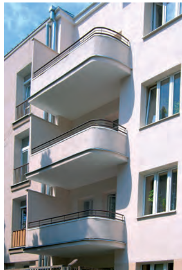
Fot. 6. Modernizacja kamienicy (naprawa tynków i wykonanie jasnej kolorystyki), która zachowała walory architektoniczne i zabytkowe, Warszawa, ul. T. Joteyki 8, 2 połowa lat 30. XX wieku. A. Widok ogólny; B. Fragment elewacji. Foto J. Lewicki, 2015.
