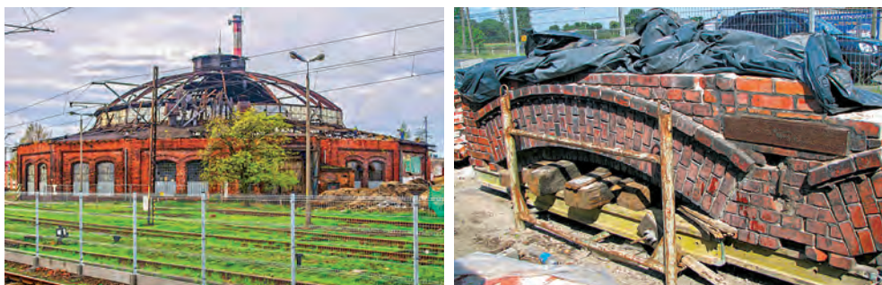
Ryc. 2. Bydgoszcz, dawna Tendrownia, stan w początkowej fazie rozbiórki /po lewej/, blok muru z detalem architektonicznym po demontażu /po prawej/. Fot. Krystian Dobosz za: Wikimedia; MKZ Bydgoszcz (patrz przypis 5)
