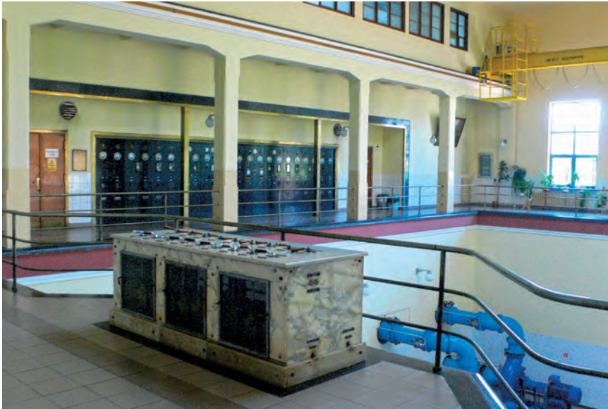
Fot. 1. Warszawa, Przedsiębiorstwo Wodociągów i Kanalizacji w m. st. Warszawie S.A., zespół Stacji Filtrów, ul. Koszykowa 81, nr rej.: A-813 z 3.1973 i A-788 z 26.03.2008. Modernistyczne wnętrze funkcjonującego Zakładu Filtrów Pospiesznych (od strony ul. Filtrowej) wzniesionego w latach 1930–1932; projektanci: arch. Antoni Jawornicki (1886–1950), inż. Zygmunt Wendrowski (1875–1939) – autor koncepcji technologicznej, inż. Charles-Jules des Bailleys (1884–1949) i jego wspólnik z Montrealu inż. Michael Charles Morsen urodzony w 1872 r. w Polsce konstruktor pierwszego w Ameryce żelbetowego kadłuba brygantyny „Concretia” dla straży granicznej w Toronto. Uroczyste uruchomienie zakładu w 1933 r. przeprowadził prezydent RP Ignacy Mościcki (1867–1945). „Zespół Stacji Filtrów Williama Lindleya” w Warszawie jest Pomnikiem Historii od 2012 r. Fot. W. Affelt, 2009
