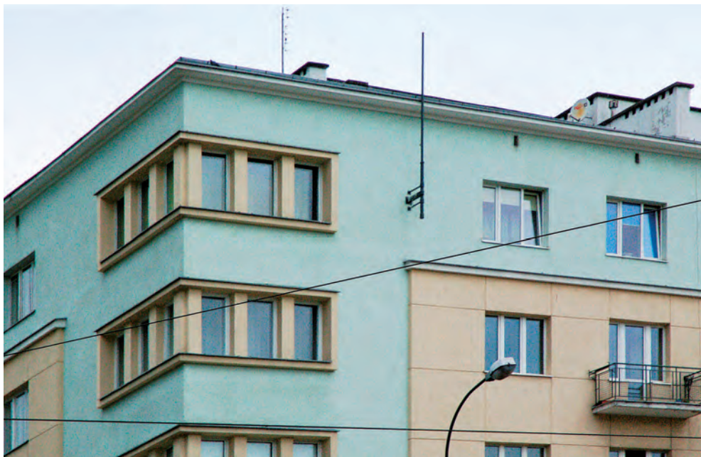
Fot. 7. Elewacja po modernizacji (docieplenie, nowe tynki i kolorystyka), której skutkiem jest ahisteryczne ukształtowanie elewacji i nowa kolorystyka, Warszawa, ul. Grójecka 34, proj. Antoni Jawornicki, 1936–37. A. Widok ogólny; B. Fragment elewacji. Foto J. Lewicki, 2015.
