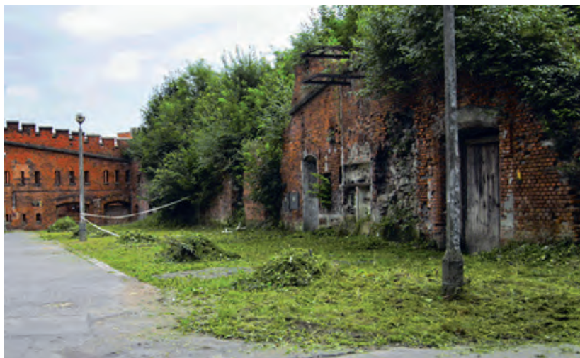
Fot. 1. Elewacja północna kurtyny przed rozpoczęciem prac w 2011 r. Fot. L. Cierpiałowski, Komitet Kopca Kościuski
