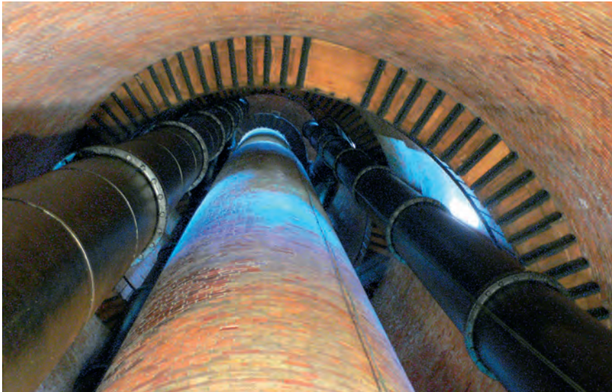
Fot. 2. Warszawa, Przedsiębiorstwo Wodociągów i Kanalizacji w m. st. Warszawie S.A., zespół Stacji Filtrów, ul. Koszykowa 81, wieża ciśnień, rejestr zabytków A-813 z 3.1.1973 i A-788 z 26.03.2008. Zbudowana w latach 1878–1886 dla systemu zaopatrzenia Głównego Miasta, eksploatowana do 1934 r.; projektant: inż. William Lindley (1808–1900). Wnętrze nie zawierało zbiornika, a dostawę wody zapewniał słup wody w rurach dystrybucyjnych o średnicy 910 mm, połączonych na wysokości ok. 26 m z rurami doprowadzającymi wodę przefiltrowaną, wyprowadzonymi powyżej i otwartymi. To rozwiązanie, eliminujące uderzenia ciśnienia w sieci jakie mogłyby powodować pulsacyjna praca parowych pomp tłokowych, straciło przydatność po wprowadzeniu pomp wirowych. Mimo wyłączenia obiektu z pracy w sieci zachował on pełną autentyczność i integralność. Fot. W. Affelt, 2009
