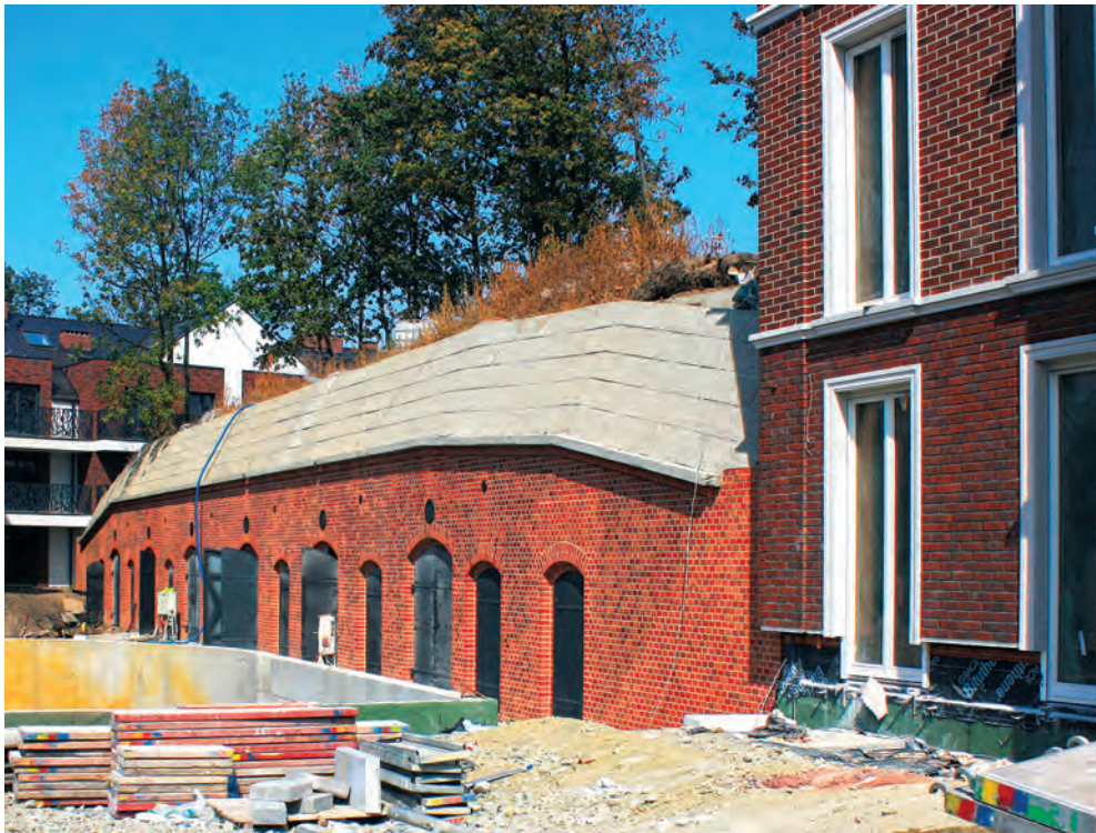
Il. 5. Schron Piechoty 1 wśród nowej, ciasnej zabudowy mieszkaniowej, 2015 (Ł. P.)
