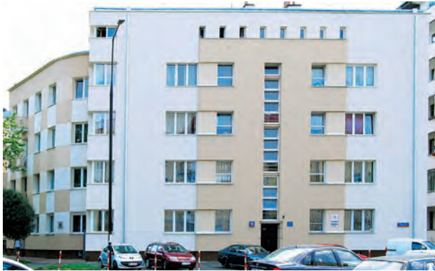
Fot. 1. Elewacja kamienicy o wysokich wartościach architektonicznych po modernizacji (docieplenie metodą lekką suchą, nowe tynki, kolorystyka i obróbki blacharskie oraz wymiana klinkieru akcentującego parter), które spowodowało zmianę plastyki przez „podcięcie” pogrubionych elewacji. Warszawa, ul. Filtrowa 64, proj. Lucjan Korngold, 1935–36. A. Widok ogólny; B. Fragment parteru z wymienionym klinkierem i wysunięciem górnej części pogrubionej elewacji. Foto J. Lewicki, 2015.
