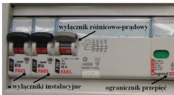
Rys. 6.17. Rozmieszczenie zabezpieczeń instalacji samochodowej 230 V
