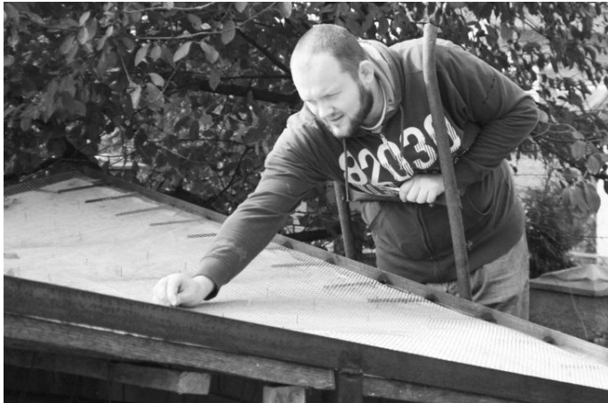
Рис. 9. Встановлення «маячків» для контролю товщини оболонки, укладання зварної сітки
