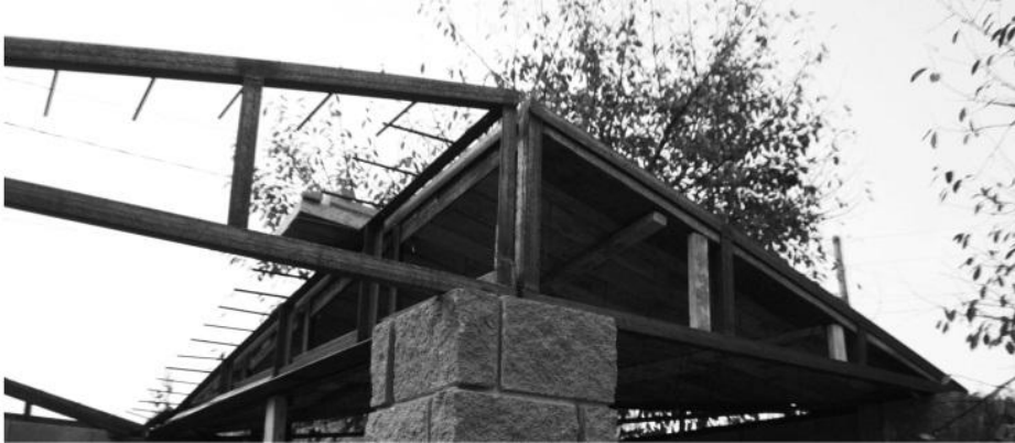
Рис. 8. Бортові елементи оболонки у вигляді металевих ферм та виставлена опалубка під одну з оболонок
