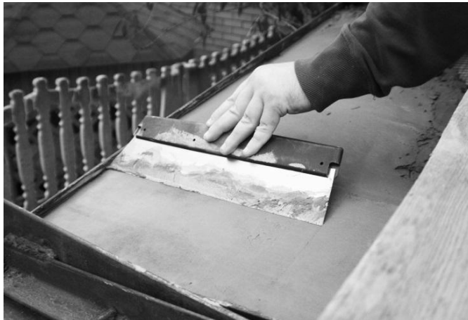
Рис. 11. Загладжування поверхні армоцементної оболонки
