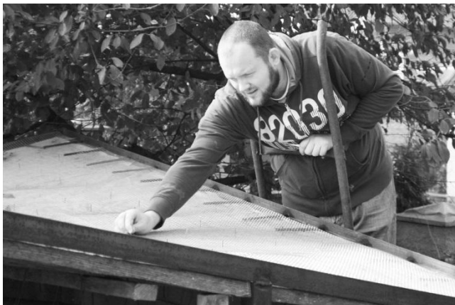
Rys. 9. Instalacja "markerów" do kontroli grubości pokrycia, położenia siatki spawanej
