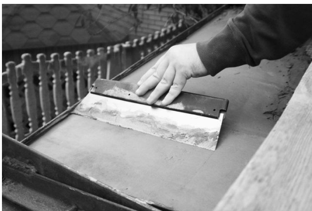
Rys. 11. Wygładzanie powierzchni pokrycia żelbetowej
