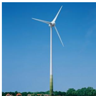
Rys. II.26d. Turbina wiatrowa E33 średniej mocy - 330 kW, firmy ENERCON [II.10]
