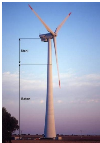
Rys. II.61. Wieża stalowo betonowa [II.9]
