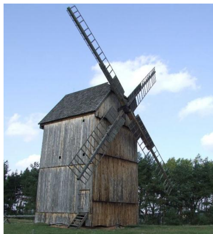
Rys. II.18. Wiatrak - typu paltrak. Osiek n/Notecią - skansen [II.8]
