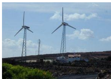
Rys. II.59. Przykłady wież elektrowni wiatrowych o konstrukcji kratownicowej [II.9]
