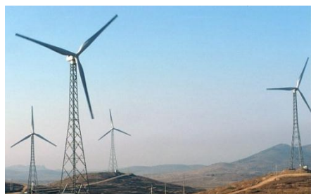
Rys. II.59. Przykłady wież elektrowni wiatrowych o konstrukcji kratownicowej [II.9]
