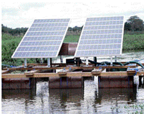
Rys. I.16. Zastosowania systemu autonomicznego bez akumulatora: a) pompy wody w Brazylii; b) dojarka do mleka [I. 33]
