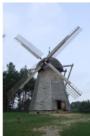
Rys. II.14. Wiatrak - typu holender drewniany [II.8]
