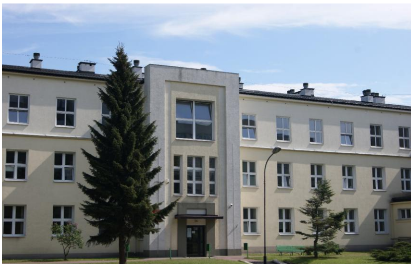
10. Budynek Wydziału Podstaw Techniki – siedziba Katedry Podstaw Techniki. Wygląd obecny (zdjęcie z 2017 roku)
