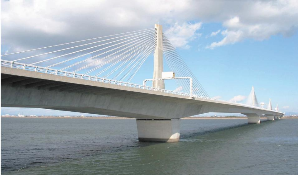
Figure 4.4.19. Free-standing pylon<sup>99</sup>
