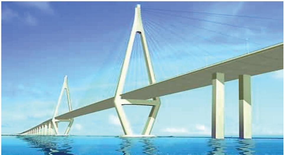
Figure 4.4.18. Deltoid pylon <sup>98</sup>
