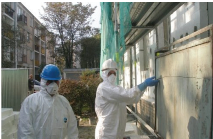
Fot. 7.1. Demontaż płyt azbestowych
